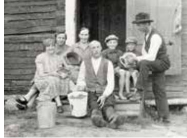
Ristilä toimi metsäradan väliasemana, jossa oli veturipuuta, vedenottoaika, ratavaihteet ja puhelin.
