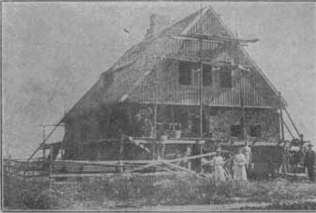
Turvetiili-rakennus tekeillä. Töiden jouduttamiseksi on vesikatto tehty etukäteen kannatusvasojen varaan
