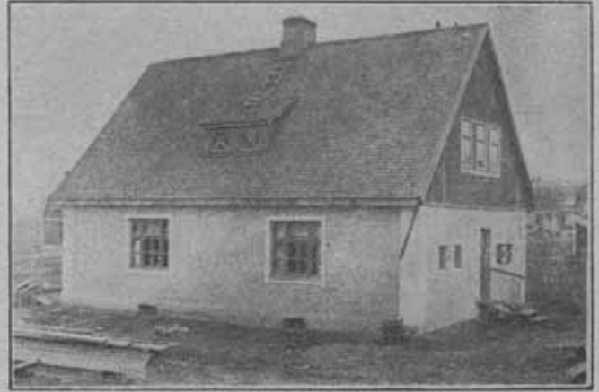
Turveteiileistä tehty rakennus valmiina. Seinät ulkoa ja sisältä kalkkilaastilla siveltyinä.
