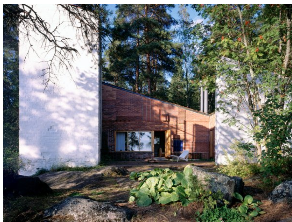
Muuratsalon Koetalon keskeisin tila on muurein suojattu sisäpiha nuotiopaikkoineen. Seinät on muurattu kokeilumielellä erilaisia tiiliä ja tiilisalvoksia käyttäen.
