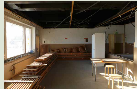
Sälekattojen ja ikkunapenkkinen laatoitusten irrottaminen ja talotekniikka-asennusten purku.
