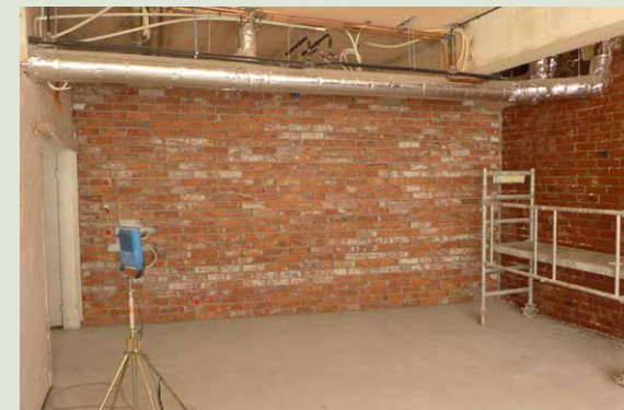
Vanhoista tiilistä murattu vino seinä peittää taakseen jäävät asennukset.
