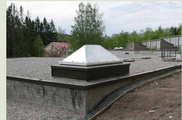
Kattoikkuna korjauksen jälkeen. Kattokuvun muoto on muutettu pyramidin malliseksi.
