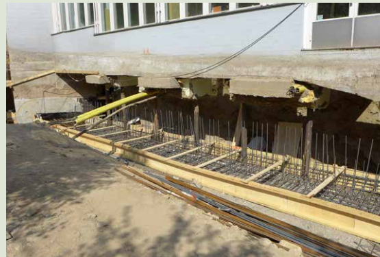
Perustusten alentaminen oli varautumista nivelosan rakentamiseen. Anturan raudoitusyöt kesken.
