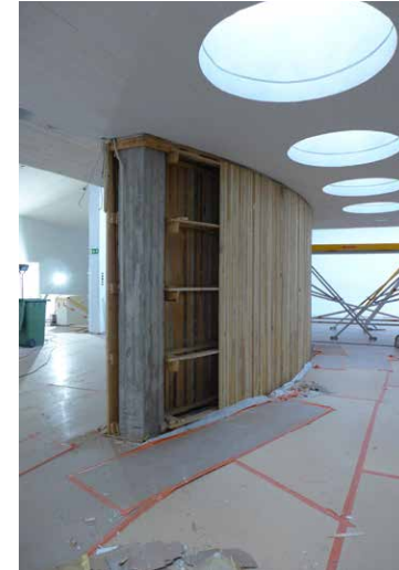
Kaarevaa seinäkettä purettiin toisesta päästä asennuksien asentamista ja kuntotarkastusta varten.
