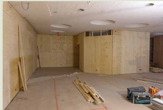
Vanerilevyjen asennus. Osa varaston ilmastointisäleiköistä on poistettu muuraamalla ne umpeen.
