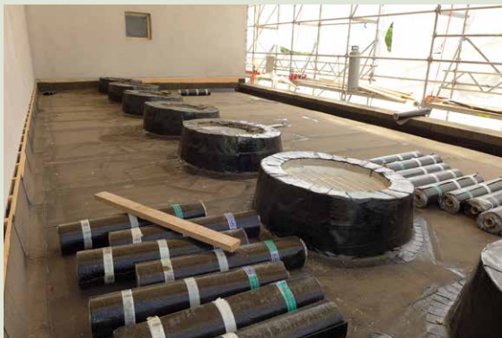
Kattoikkunoiden sekä vesikaton vedeneristäminen näyttelytilan 301 katolla.
