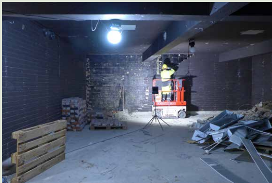
Maanvastaisen seinän sisäpuolen tiilien irrottaminen ehjänä toisen kerroksen näyttelytilassa.
