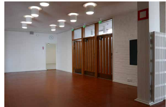
Porrashalli 302 korjauksen jälkeen. Suurin muutos on sammuttimen siirtyminen pilarin toiselle puolelle.
