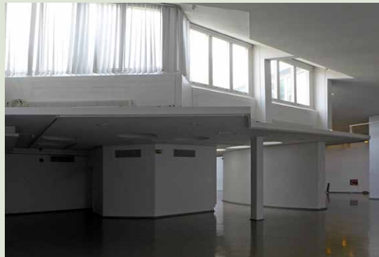
Tila kuvattuna hissien edestä ennen peruskorjausta.
