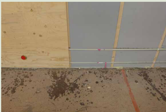
Uudet putkiin sijoitetut sähköjohdot on upotettu seinän silikaattilevyyn.
