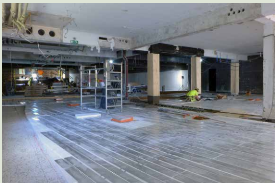
Tilan 203 uuden alapohjarakenteen lattialämmityksen asentaminen käynnissä (RM).
