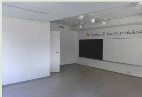
Talonmiehen asunnon paikalle tehty opetustila ennen peruskorjausta. Edessä kulku eteiseen.
