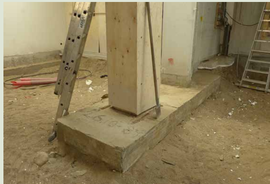
Laajennusosan pylvään anturan märkään betoniin on kirjoitettu valupäivämäärä 26.10. -89.
