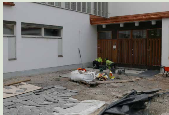
Jokaisen kiven paikka oli selvitettävä ja kivistä koottava malli ennen varsinaista uudelleen laatoitusta.
