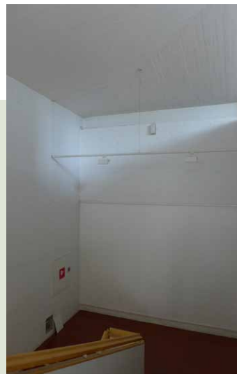
Kolmannen ja neljännen kerroksen lepotasanteella seinän levytykset ja levyn takana olevat asennukset purettiin ja uusittiin. Valaisinkisko on noussut aiempaa ylemmäs.
