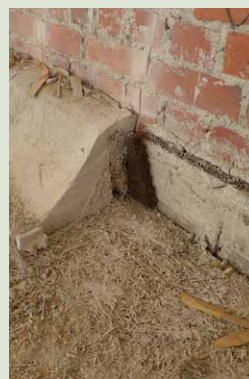
Vanhan luentosalin yläpohjan eristeitä räystäsnoston vieressä.
