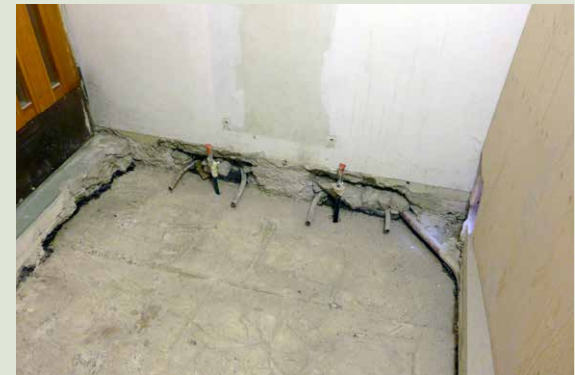
Vanhan pääsisäänkäynnin tuulikaapin lattiasa oli korkkilevyeriste, lattialämmitys sekä seinällä patterit.
