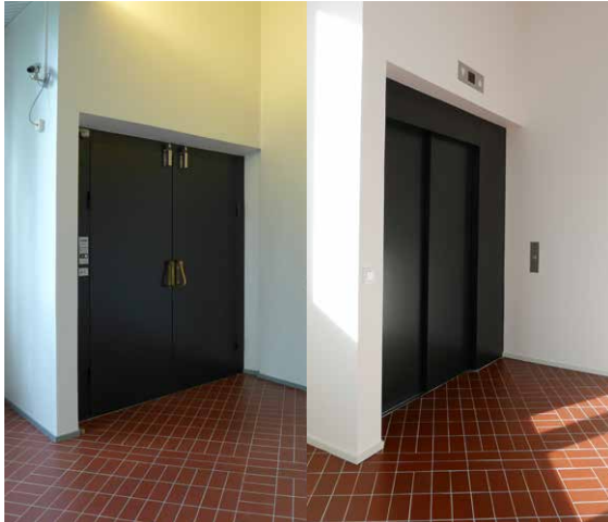
Ensimmäisen kerroksen hissin ovi ennen peruskorjausta ja sen jälkeen. Uusi hissi on esteetön.
