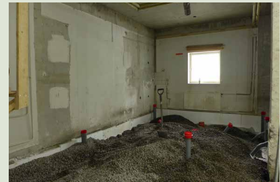
Uusia viemäriasennuksia uutta wc-tilaa sekä suihkua varten.
