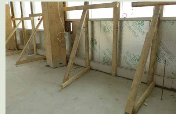
Nivelosan kohdalla olevan lasijulkisivun alaosan uudet eristeet ja aloitettu sisäpuolen muuraus.
