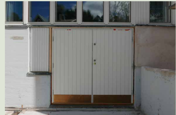
Näyttelysalin 301 pariovi on vanhan oven mukaan valmistettu uusi ovi.
