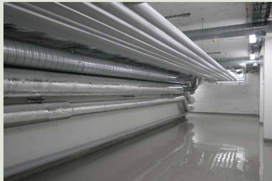
Uusi kanaali, joka kiertää rakennusta ylärinteen puolella.
