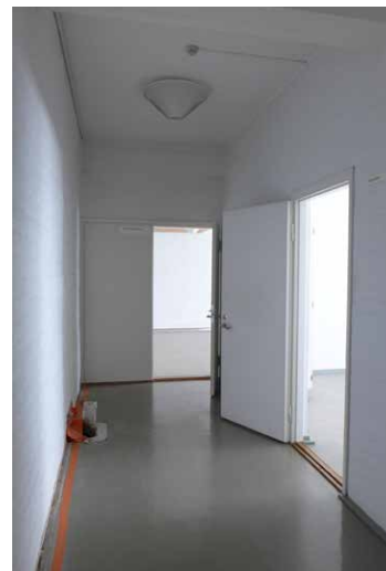
Käytävä ennen korjausta. Lattiaa on avattu rakenteen tutkimiseksi.
