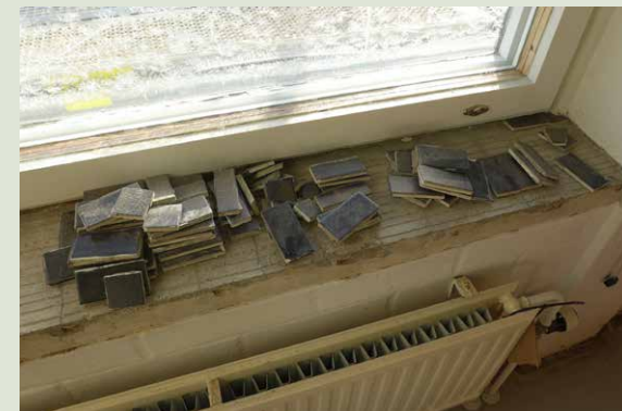
Kahvilan ikkunapenkin laattoja irrotettuna. Ehjät laatat puhdistettiin ja käytettiin uudelleen.
