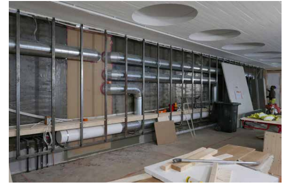
Tekniikkaseinän runkoa siirrettiin hieman ulommas uusien asennusten mahdollistamiseksi.
