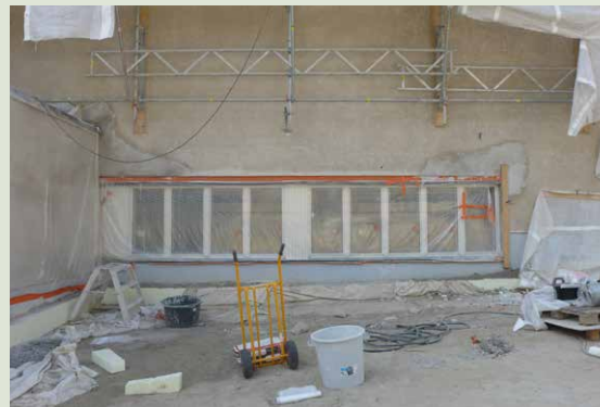
Julkisivukorjauksia ikkunan ympärillä ja ikkunan suojaukset.
