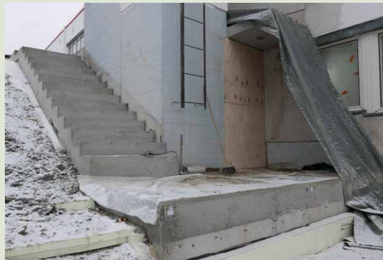
Uusi betonirunkoinen tasanne ja portaat.
