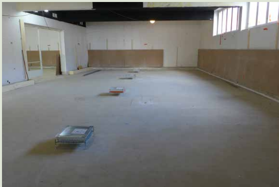
Tilan 301 epätasaisen kantavan laatan pinta on tasoitettu. Keskellä lattiaa sähkön lattiarasiat.
