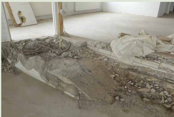
Luiska oli rakennettu entisten portaiden paikalle hyödyntäen sen vanhoja rakenteita.
