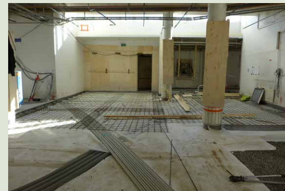
Aulan 101 uutta alapohjarakennetta. Raudoitusten ja lämmitysputkien asennukset pääoven edessä.
