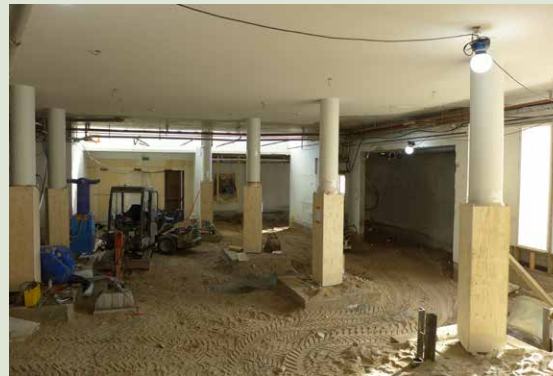
Alapohjat on purettu. Samalla purkautuivat aulan ja wc-tilojen sekä henkilökunnan tilojen väliset seinät.
