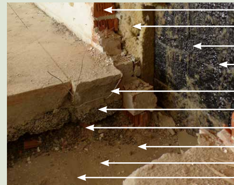
Tilan 212 alapohjan ja seinän liitoksen koepurku.
