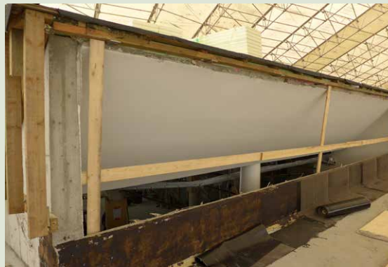
Ikkunan alapuolelle on valettu teräsbetoninosto, jota vasten vedeneristyskermejä ollaan nostamassa.
