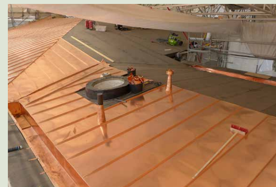
Uutuuttaan hohtavan kuparipeltikatteen asennus etenee.
