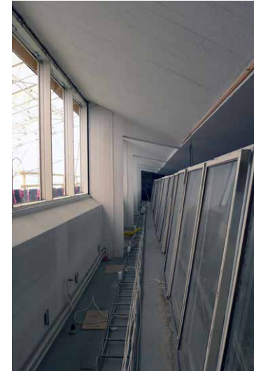
Neljännen kerroksen klerestorioikkunoiden puitteet on irrotettu kunnostamista varten.
