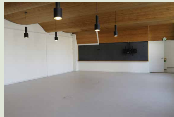
Luentosali korjauksen jälkeen. Kunnostettujen kattovalaisinten johdot ja kattokuvut uusittiin mustina.
