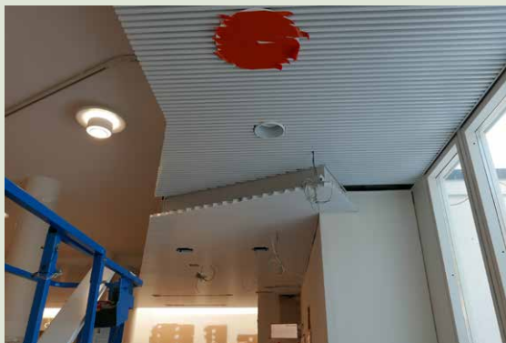
Ilmanvaihdon asennuksista johtuen sälekaton muoto poikkeaa hieman aiemmasta ikkunaseinän vieressä.
