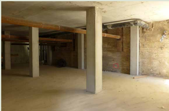
Uuden konehuoneen teräsbetonirunko on valmistunut.
