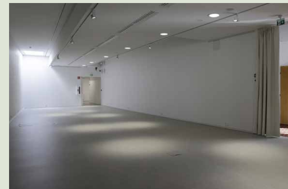
Näyttelytilan uusitut seinäpinnat, uusittu tekniikka ja valaistus. Uusi lattiapinnoite on harmaata linoleumia.
