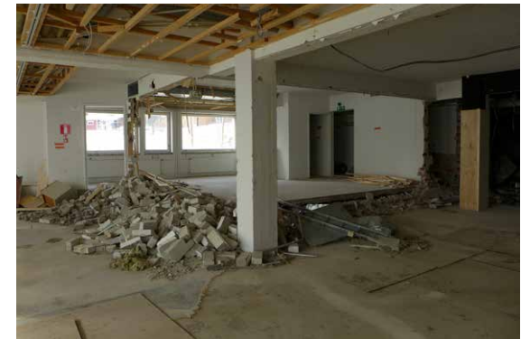
Luiska sekä osa seinistä on purettu niin että ehjät punatiilet on otettu talteen uudelleenkäyttöä varten.
