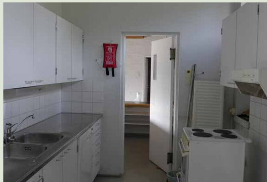
Keittiö kuvattuna tarjoilualueen suuntaan ennen peruskorjausta. Osa kalusteista on jo purettu.
