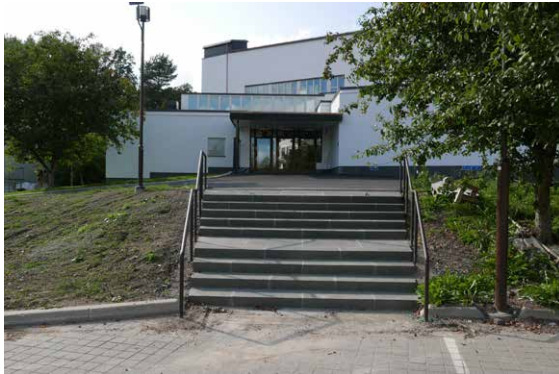
Etupihan kadulta asfaltoidulle aukiolle nousevat portaat korjattiin vanhat kaiteet säilyttäen.
