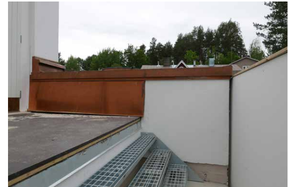
Liukuva portti korvattiin kiinteällä teräsportaalla. Vanerilla asennettiin vielä kyynellevy.
