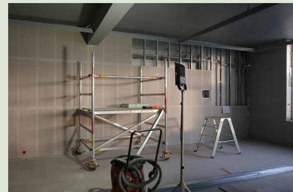
Näyttelysalin 301 liukupalo-ovi jäi akustiikkapinnoitetun tekniikkaseinän sisään.
