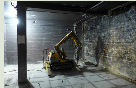
Alapohjien purkua tilassa 203B. Seinältä on purettu slammattu tiilimuuraus.
