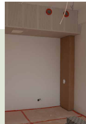
Tilan 210 uudet tekniikkakoteloinnit ennen pintakäsittelyä.
