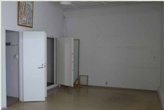
Tila 306 ennen peruskorjausta. Tila on toiminut verstaana ja vasemmalla on holvi sekä varastoja.
