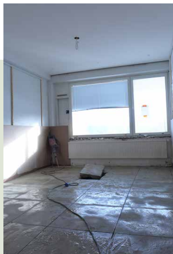
Huoneen 210 alapohjien purku ja ikkunapenkin laattojen irrotus.
