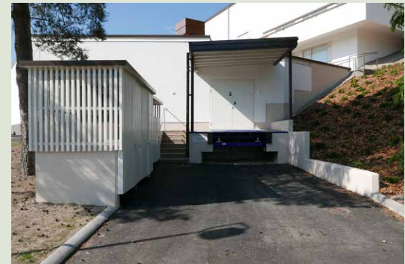
Jätesuoja ja lastauslaituri korjauksen jälkeen. Huoltoajoreitti on leventynyt jätesuojaa kaventamalla.
