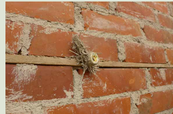
Tähti-oluen pullonkorkkia on käytetty Tojax-levyn naulauksen aluslevyinä.
