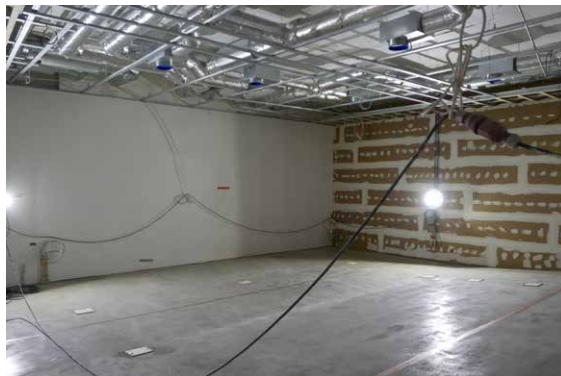
Lasketun katon teräsrungon kokoaminen, seinien taositustyöt ja lattiaan tehdyt muutokset.
