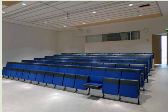
Luentosalin laskeva katsomo ennen korjausta. Sisäänkäynti tilaan on projektorihuoneen vieressä.
