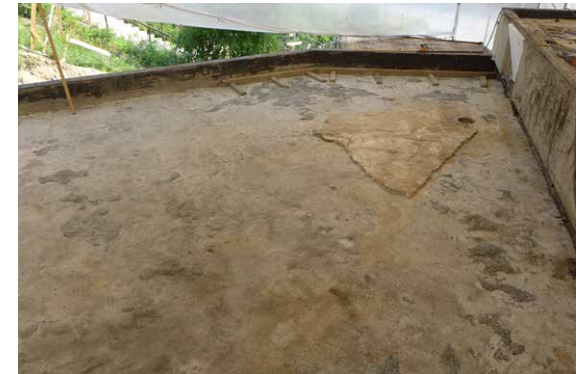
Väestönsuojan ja lastauseteisen kohdalla yläpohja purettiin betoniholviin saakka.
