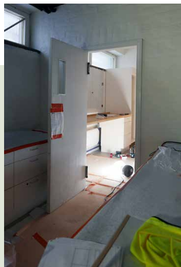
Kaluste- ja patteriasennukset me- nivät hiukan päällekkäin.
