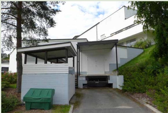
Laajennusosan lastauslaituri ja jätesuoja ennen peruskorjausta.
