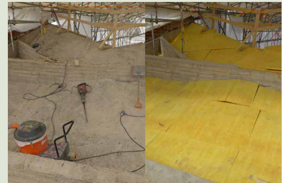
Kuvapari epätasaisesta laatasta ja sen vuoksi laatan päälle asennettavasta kovasta mineraalivillalevyistä.
