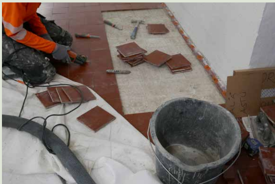
Porrashallin lattia-laattojen huolellista irrottamista ehjänä kopoalueilla.
