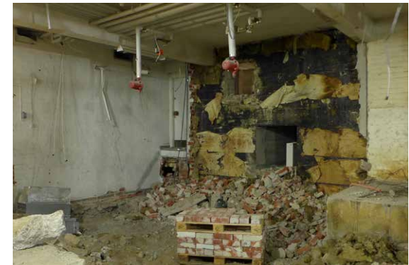
Iv-konehuoneen seinäpurkuja. Vanha savuhormi kulkee ulko-oven kohdalla vanhalle piipulle.
