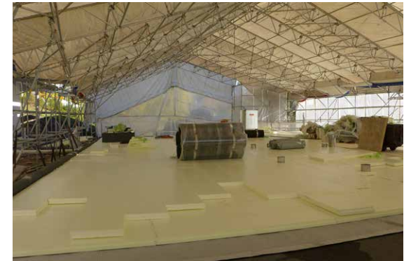
Vedeneristeiden päälle levitettiin salaojamatto ja uudet lämmöneristelevyt limittäin.
