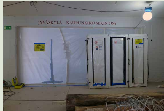
Asbestipurkujen ajaksi tila osastoitiin. Kulku tilaan oli kielletty purkujen ja puhdistuksen aikana.
