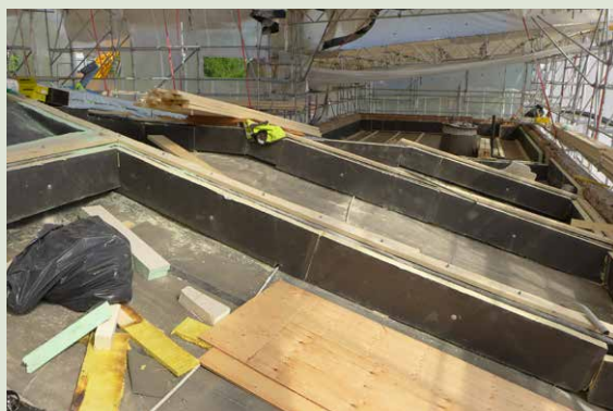
Uutta yläpohjarakennetta. Palkit ja laatta on päällystetty polyuretaanilevyllä.
