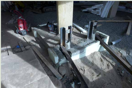
Aulan anturoiden tukemista teräspaaluilla ja niiden ympärille valetuilla suojavaikutuksilla.
