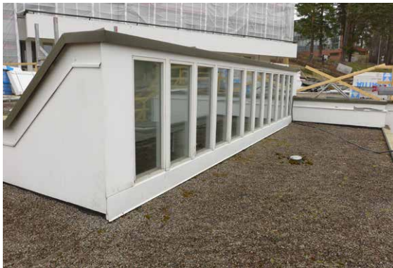
Klerestorioikkuna ennen purkutöitä.
