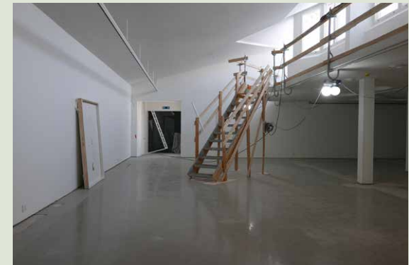
Lattiasta on poistettu laattoja seinien vierestä tiivistystöiden takia ja liikuntasauvojen kohdilta.
