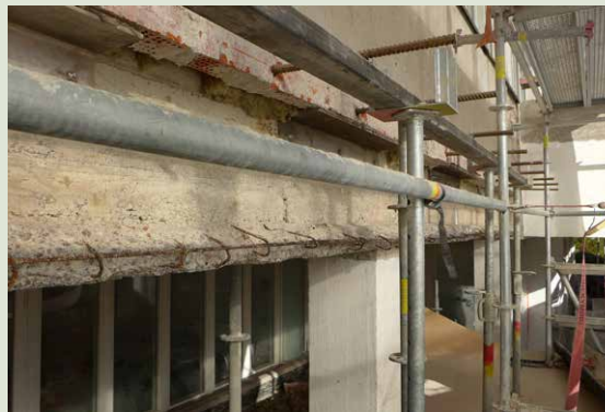
Rappaus, tiilikertoja ja mineraalivillaa purettiin vaurioituneen leukapalkin kohdalla.
