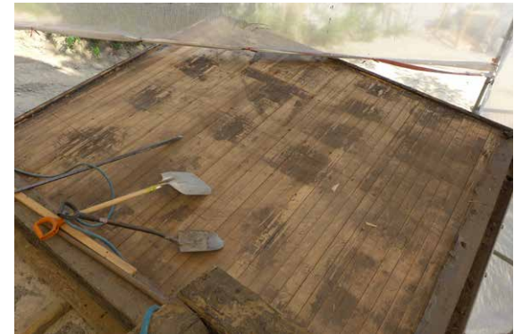
Lastauslaiturin katoksen vanha bitumikermikate on poistettu ja tilalle asennettiin uusi.
