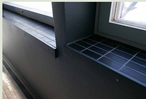
Ikkunapenkin uusi laatoitus ja harmaaksi maalattu otalista näyttelysalin 203A seinämän takana.
