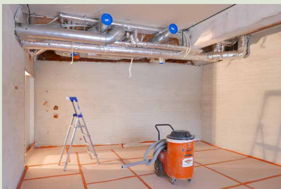
Katon tekniikka-asennukset loppusuoralla. Seinät on slammattu uudelleen.
