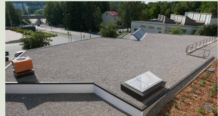
Laajennusosan katto peruskorjauksen jälkeen. Näkyvin muutos entiseen on uusi poistoilmapiippu ja uudistunut kattoikkuna.
