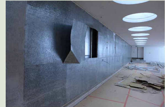
Ilmastointiseinän peltiverhous ja avatussa kohdassa näkyvä mineraalivilla purettiin, teräsrunko säilytettiin.
