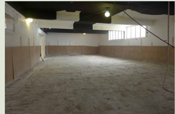
Eristetty välipohja on purettu kantavaan laattaan asti, jonka pinta oli täynnä rakentamisaikaisia painaumia.
