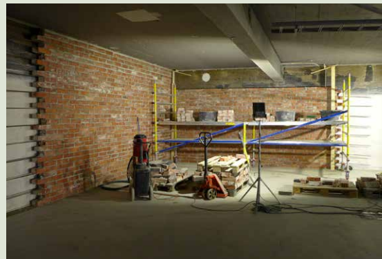
Slammatut tiilipinnat olivat säilytettäviä pintoja, mutta toisessa kerroksessa ne oli muurattava uudelleen.
