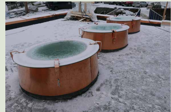
Päällyslasit on kiinnitetty uusilla vanhan mallisilla ankkuriheloilla ja kattoikkunat ovat valmiit.
