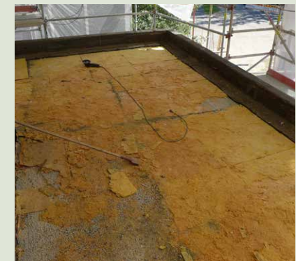
Kevytsorabetoni ja sen päällä oleva mineraalivillalevytilan 106 kohdalla.
