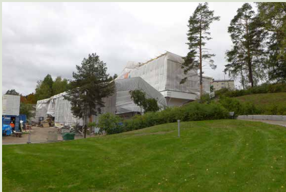
Rakennuksen vesikate- ja julkisivukorjaukset toteutettiin sääsuojan sisällä.
