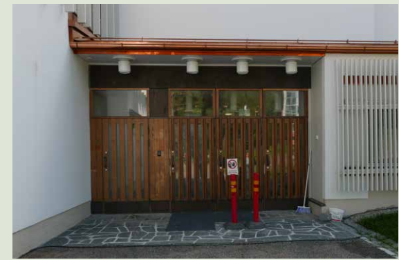
Vanha sisäänkäynti perusnäyttelyiden rakentamisen aikaan. Laatoitus saatiin onnistuneesti palautettua.
