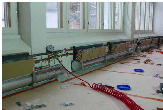
Suutinkonvektorien asennustyöt.
