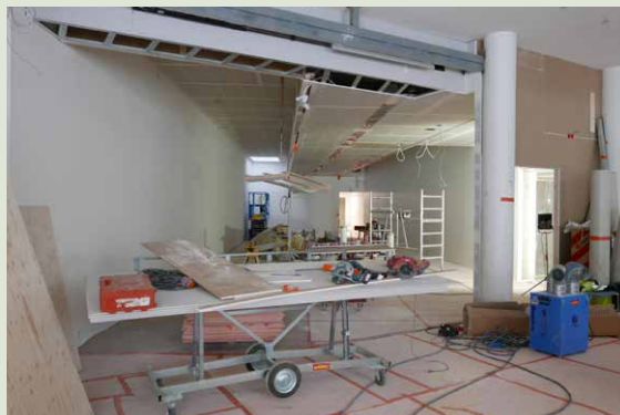
Uutta lasiseinää ja -liukuovea varten kiinnitettiin teräspaalu pylvään ja seinän väliin.
