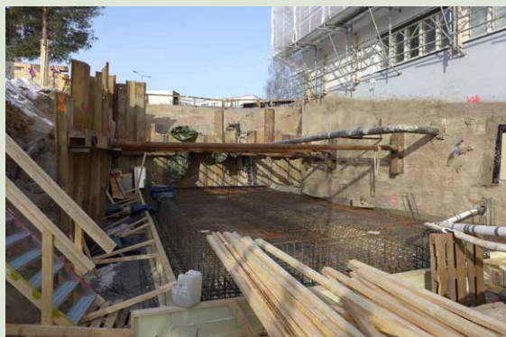
Maanalaisen iv-konehuoneen alapohjan teräsbetoni-laatan raudoitukset valmiina.
