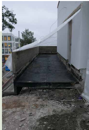
Purkutöissä betoni puhdistettiin jyrsimällä bitumi pois.
