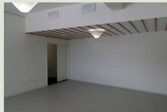
Tila peruskorjauksen jälkeen. Tilan A622A-valaisimet on palautettu paikoilleen kunnostettuna.
