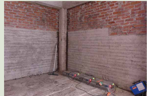
Seinät on purettu ulkomuuraukseen ja betonimuriin asti. Eristeväliä kuivataan tasokuivaimilla.
