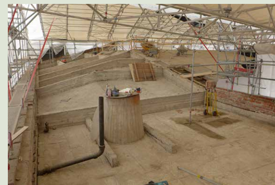
Katon purkutyöt ovat loppuvaiheessa. Vesikattotyöt tehtiin sääsuojan alla.
