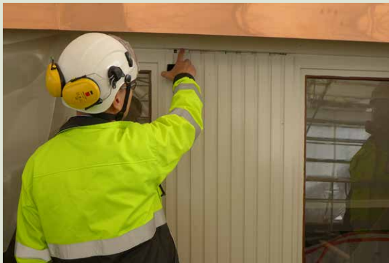
Antti Souto (A-Insinöörit Oy) tarkastelee ikkunoiden paneloitusten väliä toteutusta.
