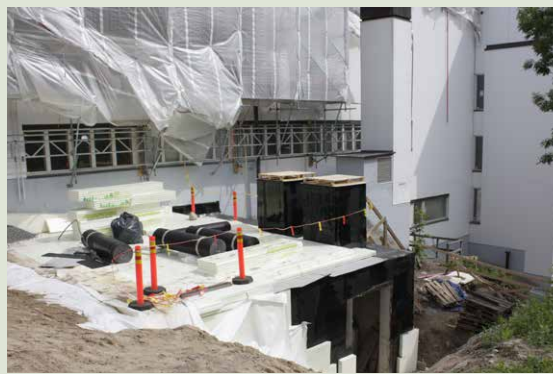
Konehuoneen betonirunko on valmistunut ja eristeiden asennus sekä maantäyttö käynnissä (RM).
