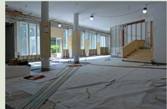
Alapohjan uusiminen. Pylväiden välissä on uuden asiakaspalvelutiskin sijainti (RM).
