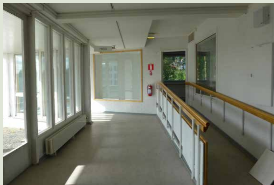
Opetustilaksi muuttamisen yhteydessä toteutettu luiska, uusi väliseinä ja hissille vievä käytävä.
