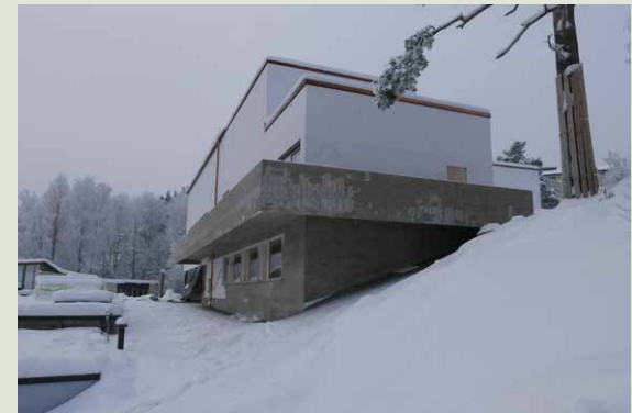
Parvekekaide puhdistettiin vanhoista maaleista ja samalla poistettiin aiemmin tehty paikkakorjaukset.
