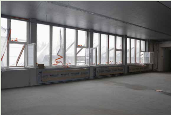
Uusia lämpöpattereita on asennettu kolmannen kerroksen näyttelysalin ikkunaseinälle.
