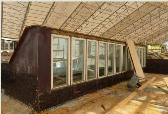
Pintaverhousmateriaalit ja seinän alaosaan nostettu bitumikermi on poistettu.
