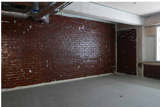
Ulkoseinien slammaus on poistettu ja seinälle tehty tiivistyskäsittely.
