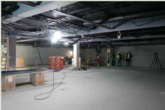
Arkkitehti Jyrki Iso-Aho ja työmaamestari Pasi Auvinen tarkastavat alakaton malliasennusta.
