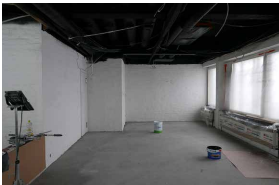
Lattia on tasoitettu ja ikkunaseinälle asennettu uudet lämpöpatterit. Maalaustyöt ovat käynnissä.
