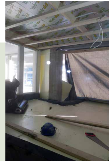
Katossa uusi lämmöneristys on kiinnitetty betoniholviin ja ripustusrunkon tekeminen on kesken.
