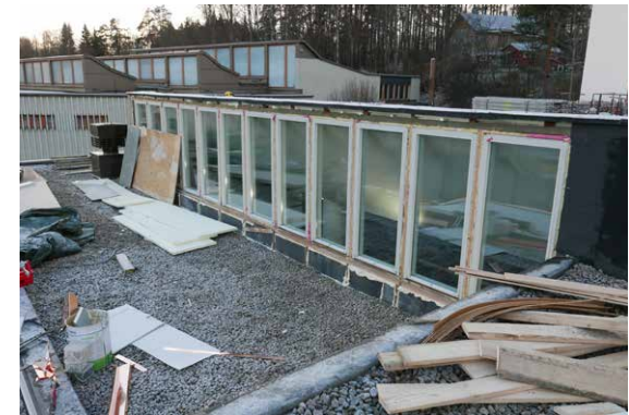
Kunnostetut ikkunat on palautettu paikoilleen.
