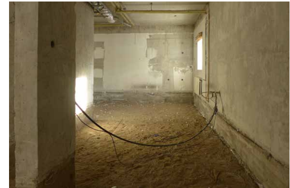
Tilojen väliseiniä purkautui alapohjan purkamisen yhteydessä. Takana kuvassa pukuhuoneen 106 alue.
