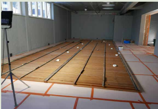
Kahvilan puusälekaton osat on koottu näyttelysalin lattialle kunnostusta ja palautusta varten.
