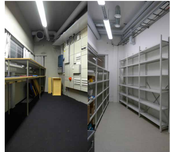
Projektorihuone ennen ja jälkeen korjauksen. Tilan käyttötarkoitus on muuttunut.
