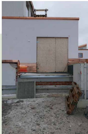
Lastaussillan leventäminen ja sitä varten tiilimuuratun räystäskorotuksen poistaminen on purettu puoli metriä.
