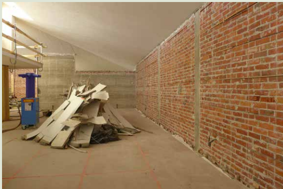
Sisäseinien pintamateriaalien purkutöitä. Puretut sementtilastuvillalevyt odottavat siirtoa kierrätykseen.
