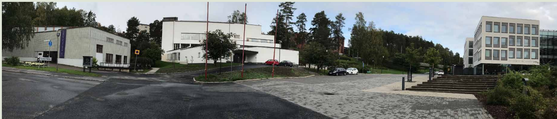
Panoraama Ruusu puiston rakennuksista: vasemmalla Alvar Aalto -museo, keskellä Keski-Suomen museo ja oikealla, kadun toisella puolella Jyväskylän yliopiston Ruusu puisto-rakennus.
