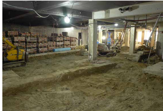
Toisen kerroksen alapohjapurkujen yhteydessä esiin tulleita aiemmin purettujen väliseinien anturoita.
