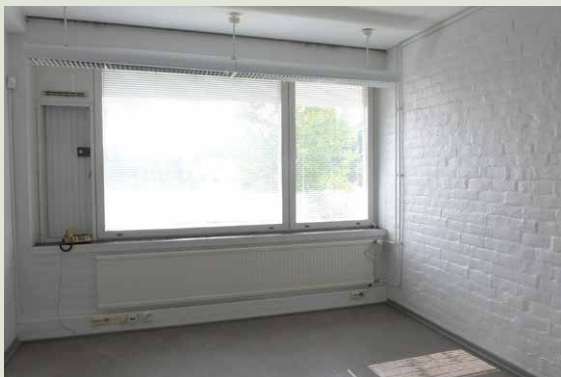
Huone 210 ulkoseinän suuntaan kuvattuna.
