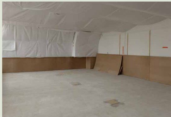
Lattian pintamateriaali on poistettu. Seinien alaosat ja erityisesti puinen alakatto on suojattu.
