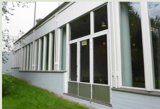
Uuden osan ikkunaseinä, jonka kohdalle nivelosan on määrä tulevaisuudessa valmistua.
