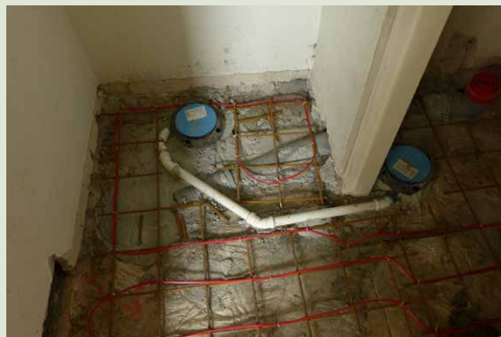
Kolmannen kerroksen wc-tilojen lattioihin tuli sähkölattialämmitys.
