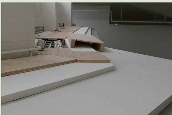
Johtokourut ja valaisipaikat suojattiin vanerikotelolla ja lipan päälle asennettiin akustiikkalevytyt.
