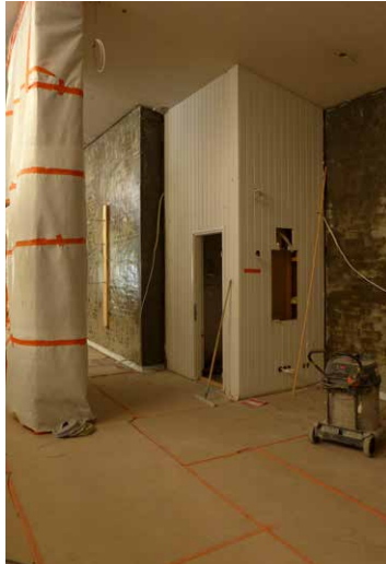
Siivoukskameran paneeleita vaihdettiin, kun seinästä poistuneen ohjauskeskuksen aukko ummistettiin.
