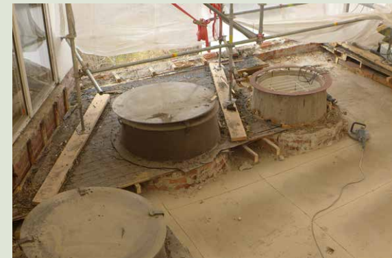
Näyttelysalin 401 kattoikkunoita purkamisen eri vaiheissa.
