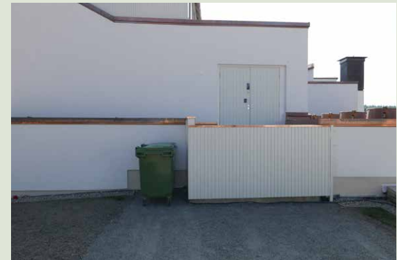
Levennetty lastauslaituri korjauksen valmistuttua.
