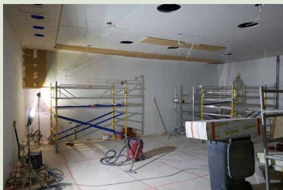
Kattomateriaali vaihtuu salin reunoilla. Puusäleiköt ja listat palautettiin katon keskiosaan.
