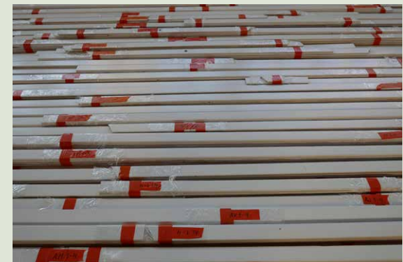
Sisäänvedon katon paneelit litteroituina ja valmiina palautettavaksi takaisin paikoilleen.
