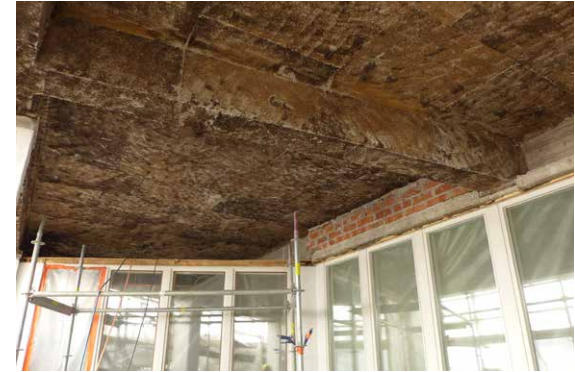
Korkkilevyt on poistettu, mutta pinta on vielä puhdistamatta jäänteistä. Myös palkin uloke purettiin.
