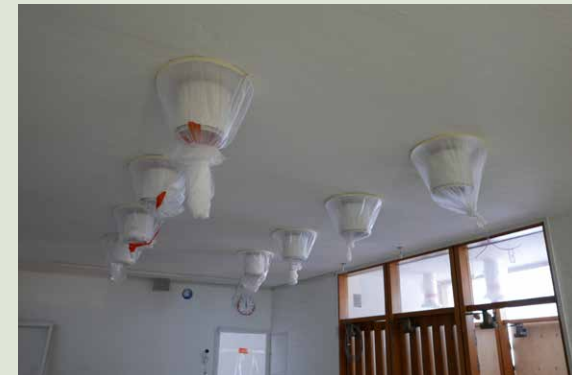
Kunnostetut valaisimet on suojattu asentamisen jälkeen, sillä tilassa tehdään yhä pölyviä töitä.
