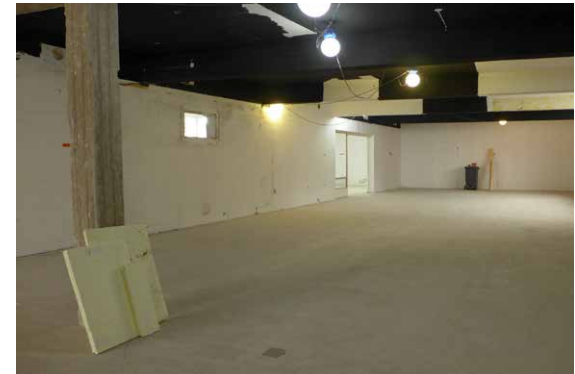
Sisäänkäynnin puoleinen osa näyttelysalia lattialaatojen purkamisen jälkeen.
