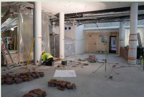
Aulan lattian uudelleenlaatoitus käyttäen vanhoja puhdistettuja laattoja sekä uusia laattoja.
