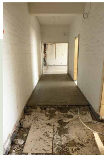
Lattian uusi valu. Vasemmalla irtotetut ja takaisin muuratut tiilet.
