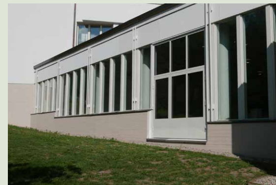
Laajennusosan kunnostettu ikkunaseinä.
