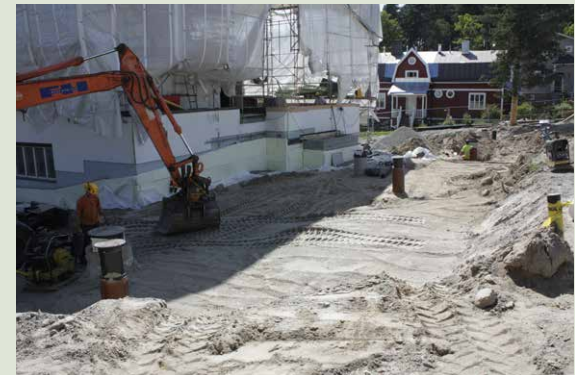
Maantäyttö- ja pihatöitä iv-kanaalin kohdalla sekä uusitut sadevesikaivot (RM).
