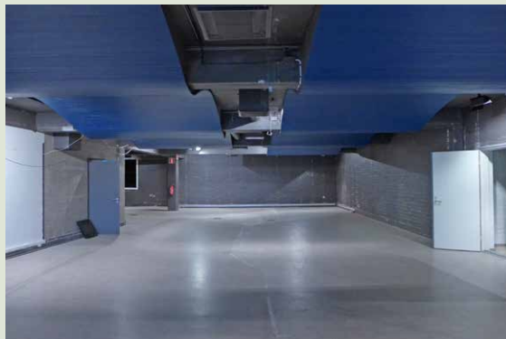
Näyttelytila ennen peruskorjausta. Vasemmalla iv-konehuone ja takana näkyvä entisen halkokuilun aukko.
