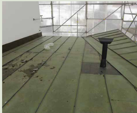
Alkuperäinen kuparikate kahvilan 310 kohdalla. Peltiä on paikoitellen uusittu.
