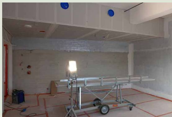
Kipsilevyn sijaan alakaton levytys toteutettiin akustikkalevyillä ja -pinnoitteilla.
