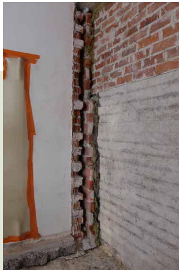
Tilasta 306 kosteusvaurioiden takia purettu seinärakenne. Betonipinnalta on poistettu bitumisively.
