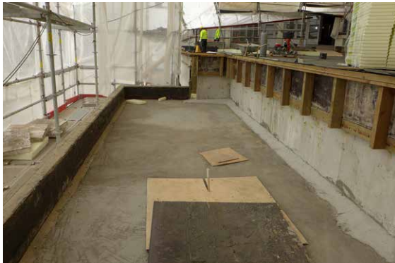
Alemmalla kattotasolla on kevytsorabetonin päälle tehty uusia kallistusvaluja.
