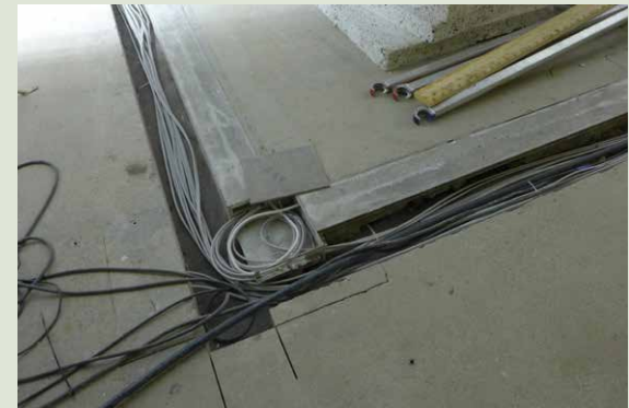
Lattiasa olevia asennuskouruja suurennettiin, sillä uudet kaapelit eivät mahtuneet vanhaan kouruun.
