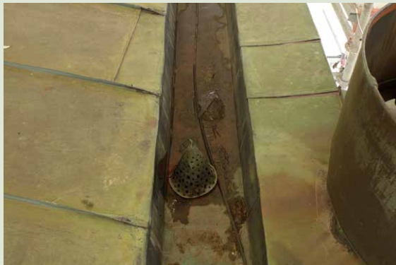
Upotettu räystäskouru sekä alkuperäinen kartion muotoinen sadevesikaivon sihti.
