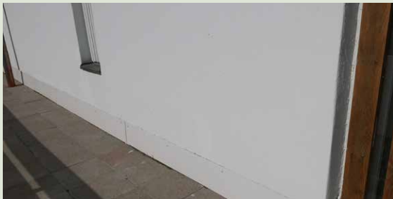
Kuvasarja vanhan kahvilan oven vieressä olevan halkeaman korjauksesta.
