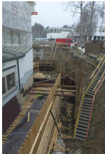
Rakennusta maan alla kiertävä iv-kanaali on edennyt seinien muottilaudoitusvaiheeseen.
