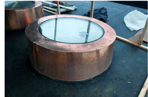
Uusi umpiolasielementti on asennettu ja ulkopuoliset kuparipellitykset ovat valmiit.
