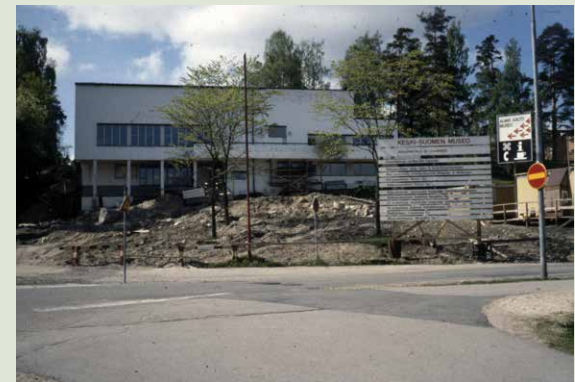
Laajennusosan rakentaminen. Kuvaaja: Marjo-Riitta Simpanen (OSC:n tiedemuseon arkisto K4076:86).
