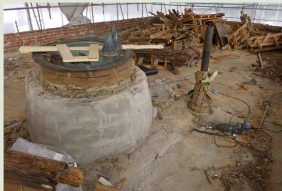
Luentosalin kattoikkunassa on alaosassa tiilimuuraus ja lasivillamatto lämmöneristeinä.
