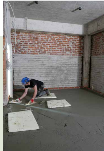
Uuden betonisen pintalaatan valuu ja tasoitus.
