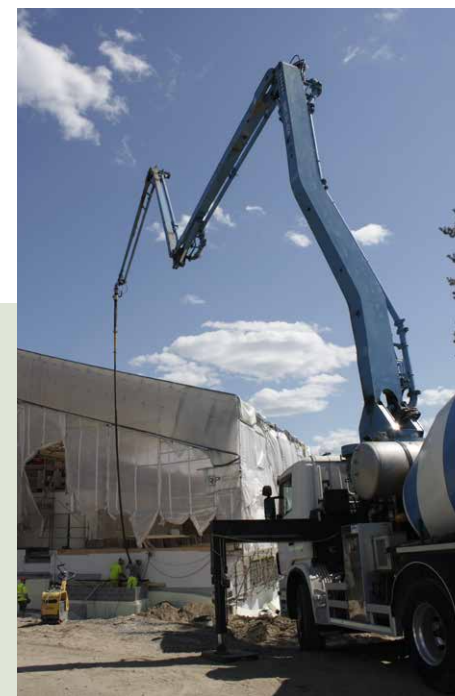
Valutyöt käynnissä uuden savunpoistokuilun kohdalla sekä maanpinnan tasoitus iv-kanaalin päällä (RM).
