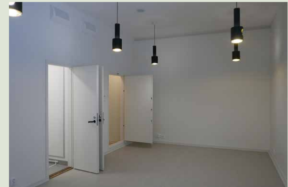
Tila laajan korjauksen jälkeen. Kattoon on asennettu akustiikka-alakatto ja Artekin A110-valaisimet.
