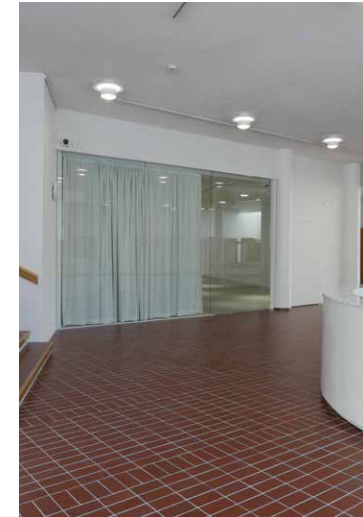
Uusi lasiseinä liukuovineen valmiina. Vakioilmastoinnin vuoksi tila oli erotettava aulasta lasiseinillä.
