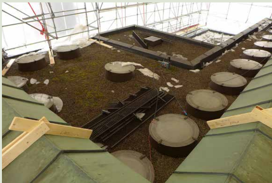
Näyttelysalin 401 katossa olevia kattoikkunoita ennen purkutöitä.
