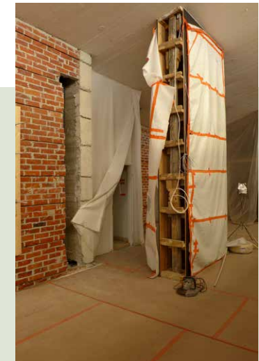
Seinää ja seinäkkeen päätä on avattu talotekniikan uusimiseksi.
