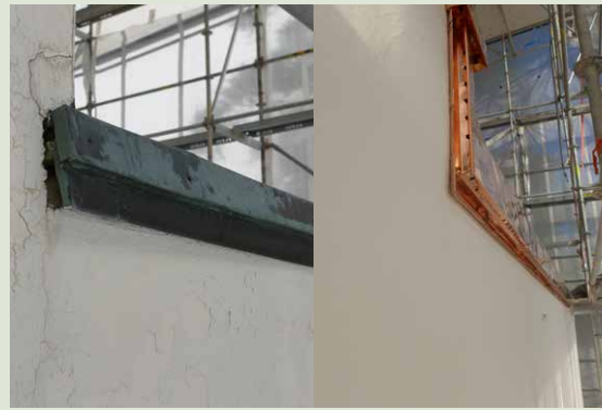
Räystäisiin tehtiin muutoksia vaurioiden ehkäisemiseksi ulkonäköä mahdollisimman vähän muuttamalla.
