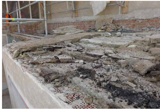
Tilan 306 yläpohjan purkutyöt. Katon kallistukset oli toteutettu eristekerroksilla.
