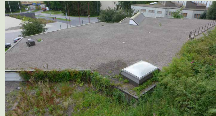
Laajennusosan tasakatto ennen peruskorjausta. Katto oli uusittu vuonna 2004.
