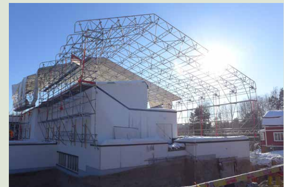
Sääsuojan rakentaminen ja iv-kanaalin kaivanto.
