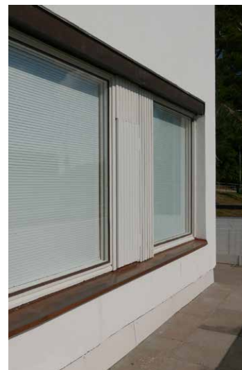
Kahvilan ikkunoita peruskorjauksen valmistuttua.
