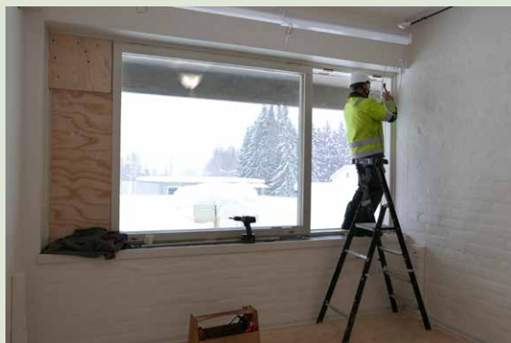
Puuseppä Erkki Toivainen tekee saranoiden paikkojen vaihtamiseksi tarvittavia muutoksia karmeihin.
