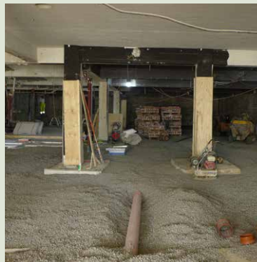
Tilan 203 uusi sepelitäyttö radon- ja viemäriputkistoinen.
