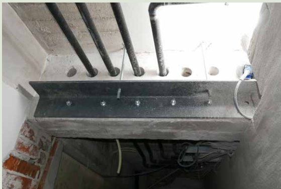
Painunut ja asennusreittien rei'ittävä palkki tuettiin välipohjaan kulmateräksen ja ankkuritankojen avulla.
