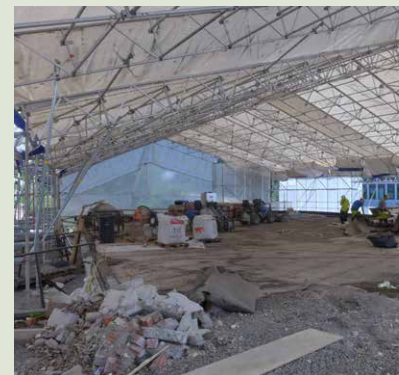
Yleiskuva katon vanhojen kerrosten purkamisesta (RM).
