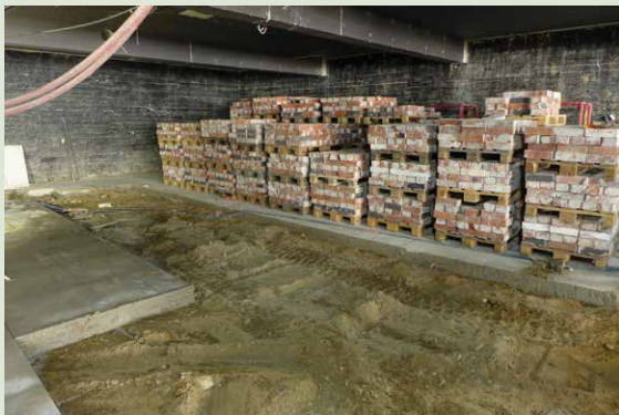
Näyttelysalin 203 eristämättömän alapohjan purkutöitä. Sisäseinän tiiliä varastoituna taustalla.
