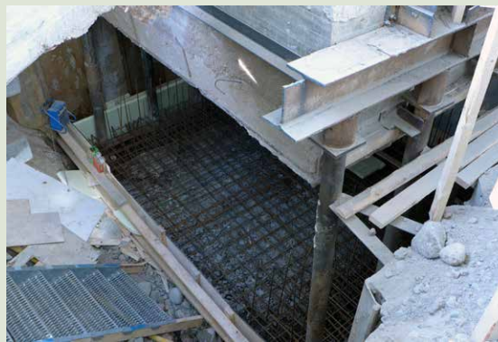
Uuden pohjalaatan raudoitukset, teräspaalaus ja väliaikaiset tuennat.
