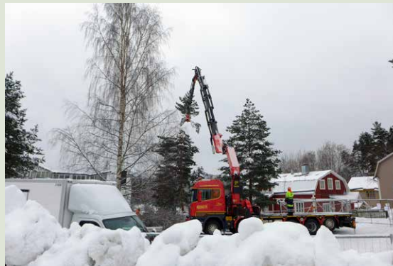
Konehuoneen paikalta kaadetaan mäntyä. Moni suuri puu jouduttiin kaatamaan kaivantojen takia.
