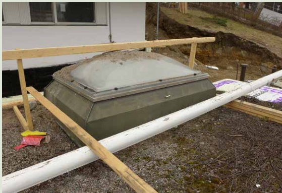
Kattoikkuna ennen vesikaton purkutöitä.
