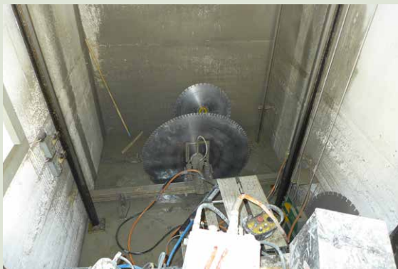
Vanhan pohjalaatan sahaaminen.
