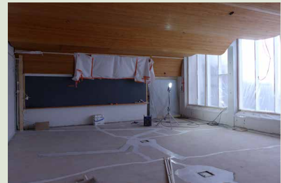
Nurkassa olevan asennusreitit työt ja lattian tiivistykset.
