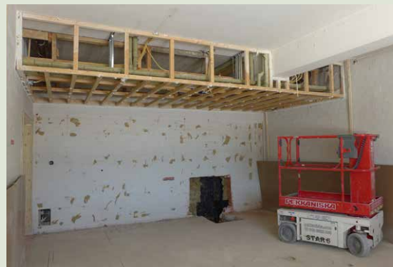
Purkutöiden aikana paljastui kaksi eri-ikäistä ja erikoista lasketun katon puurunkoa.
