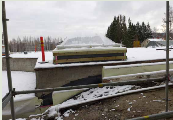
Kattoikkunan jalustan runko ja lämmöneristykset ovat valmiit ja jalusta odottaa uutta peltiverhousa.
