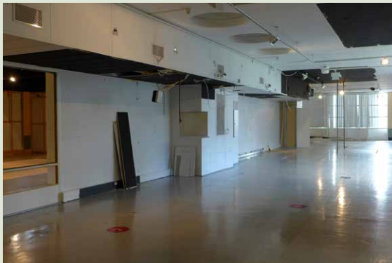
Näyttelysalin eteläinen puolisko ennen peruskorjauksen alkua. Iv-kanavia peittävät koteloinnit purettiin.
