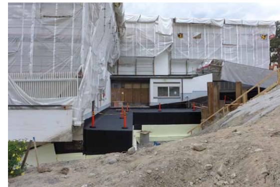
Kanaalin seinien ja katon veden- ja lämmöneristystyöt ovat meneillään vanhan pääoven kohdalla.
