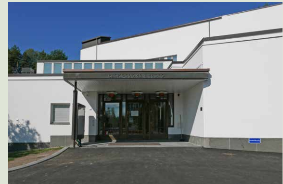
Museon pääsisäänkäynti korjauksen jälkeen. Rappuralli on väliaikainen näyttelyiden rakentamisen ajan.
