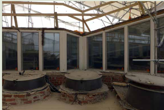
Neljännän kerroksen klerestorioikkunoita vesikaton purkutöiden aikaan kuvattuna.
