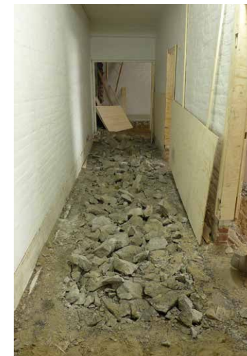
Käytävän alapohjan purkutöissä on meneillään pintalaatan purku.
