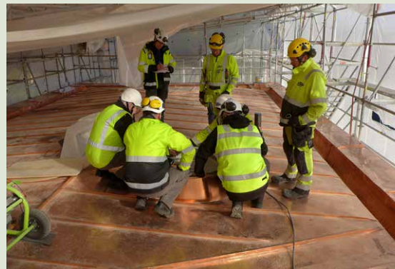
Luentosalin 404 ikkunan ympärille on kokoonnuttu keskustelemaan kattoikkunan rakennratkaisusta.
