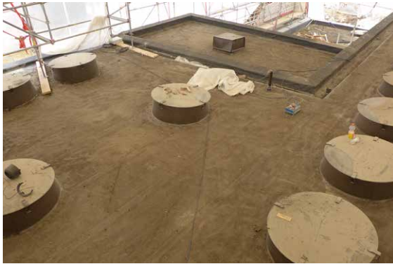
Tasakattoalueilla suojasora on poistettu ja kermikatteen purku on valmiina alkamaan.
