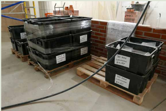
Ala-aulan lattialaatat irrotettiin ehjinä, pakattiin huolellisesti ja varastoitiin merkittynä korjauksen ajan.
