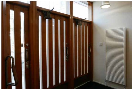
Tuulikaappi 303A korjauksen jälkeen. Seinällä on uusi vanhan mallinen lämpöpatteri.
