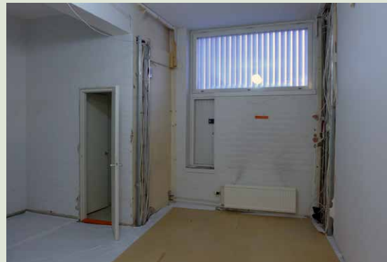
Ikkunan molemmin puolin on purettu tekniikka-asentusten kotelointeja.
