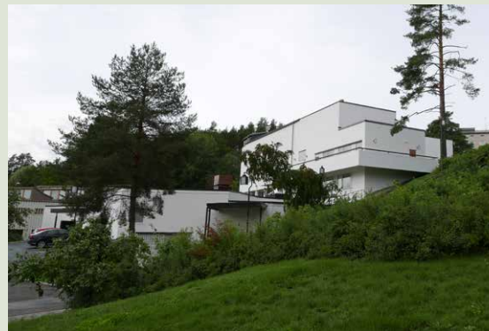
Museorakennus puistosta kuvattuna kaksi vuotta myöhemmin syyskuussa 2019 korjauksen jälkeen.
