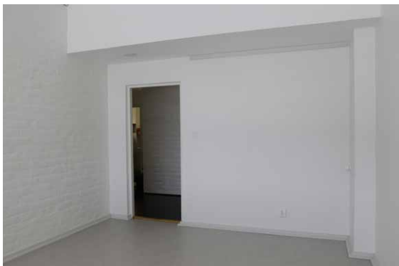
Huone 210 peruskorjauksen jälkeen. Kaappi on poistunut ja laskettua alakattoa ei enää ole.
