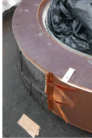
Yksityiskohta reunan rakenteista ennen umpiolasielementin asentamista sekä kuparipellityksen teko.
