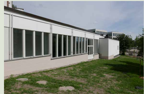
Siniset sokkelit maalattiin väritutkimuksissa löytyneen vanhimman värikerroksen mukaan vaaleanruskeaksi.
