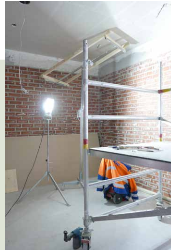
Katon levytystyöt. Seinät on muurattu uudelleen.
