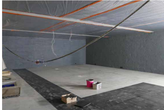
Lattialaatoitustyöt ovat kesken ja alakatot on suojattu pölyntyymisen estämiseksi.
