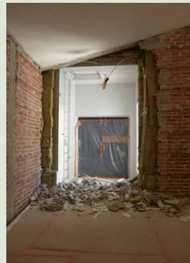
Hissitornin ja vanhan osan karkeasti tehty liittymäkohta purettiin ja rakennettiin uudelleen.
