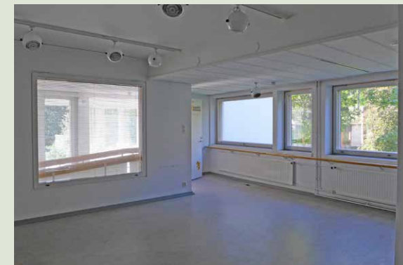
Opetustila kuvattuna ikkunoiden suuntaan ennen peruskorjausta.
