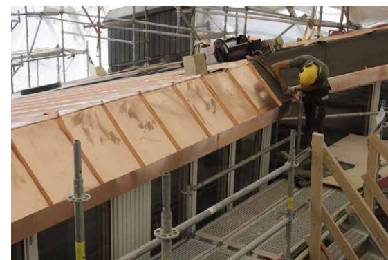
Uuden kuparikatteen asentaminen näyttelytilan yläikkunoiden kohdalla (RM).
