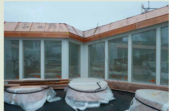
Ikkunat kunnostettuna korjauksen loppuvaiheessa. Keskeneräiset kattoikkunat on suojattu sateelta.
