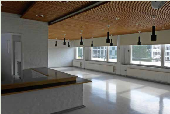
Vanha kahvila ennen korjaustöiden alkamista.
