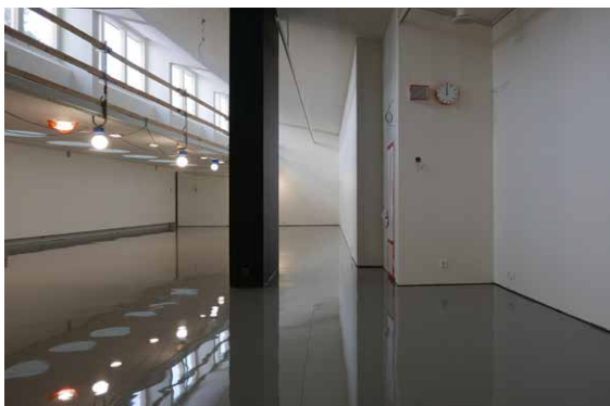
Vanhan laatan sävyyn valmistettu epoksinnoitelattia oli valmistuttuaan hyvin kiiltävä.
