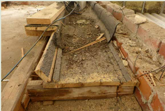
Tasakattojen upotettujen kourujen puurakenteet. Laudoitus ja vedeneristeet oli uusittu 2004.
