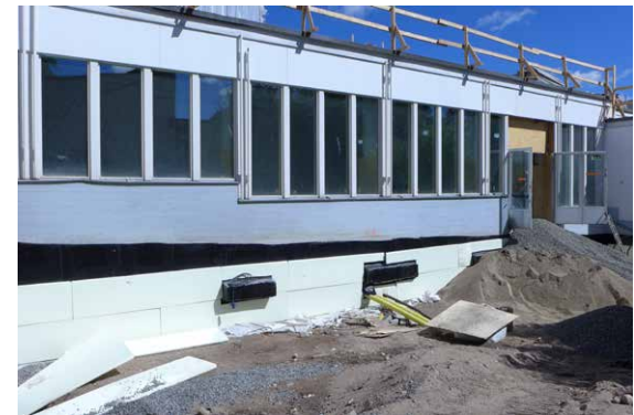
Alennettuun seinään asennettiin väliaikainen eristys. Maanpinta täytettiin vanhaan tasoon.
