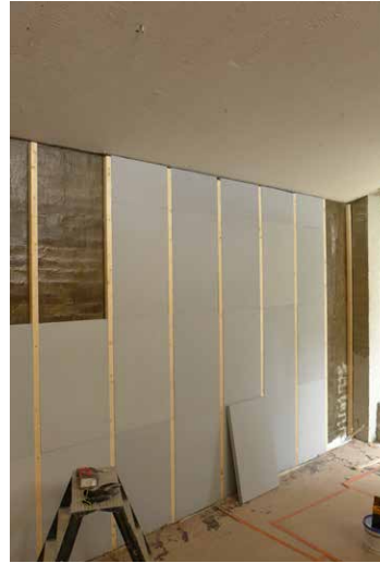
Puukoolauksien ja kalsiumsilikaattilevyjen asennus.
