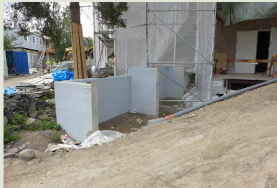
Jätesuojan purkutöiden jälkeen jäljellä oli kavennetut betoniseinät. Edessä väliaikainen reitti työkoneille.
