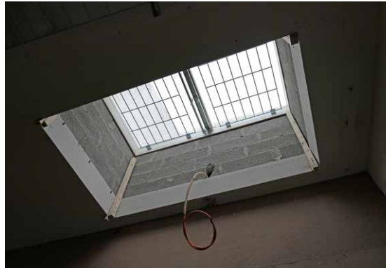
Kattoikkunan uusi jalusta ennen sisäpuolisia pintatöitä.
