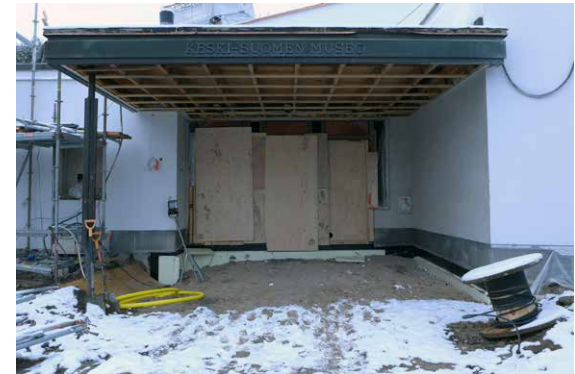
Katoksen panelointi on purettu. Alhaalla valmistautetaan uuden eristeen asentamiseen ja laatan valuu.
