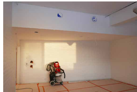
Uusi alakattopinnoite on levitetty ja seinät maalattu uudelleen.
