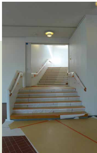
Portaikko askelmien suojausta laajennusosassa ennen korjausta.
