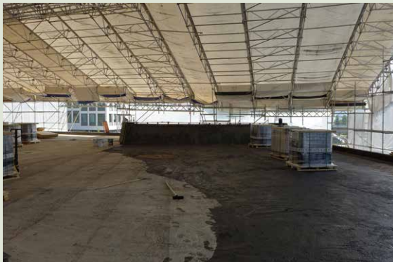
Puhdistetun betonilaatan käsittely bitumisivelyllä ennen bitumikermien kiinnitystä.
