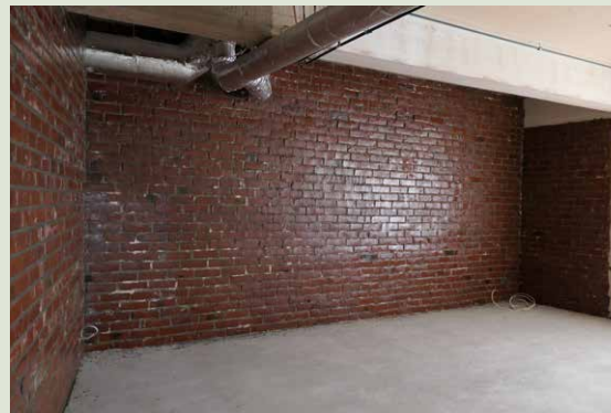
Huoneen 212 tiilipinta on käsitelty tiiviiksi. Tämän jälkeen seinä slammattiin uudelleen.
