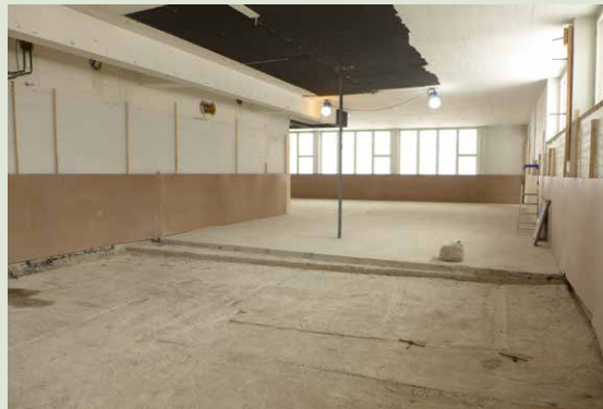
Tilan 301 eristetty välipohjarakenne on purettu. Takana näkyvä eristämätön lattiarakenne säilytettiin.
