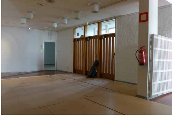
Porrashalli 302 ennen korjausta. Lattian punainen laatoitus on suojattu näyttelyn purkamisen vuoksi.
