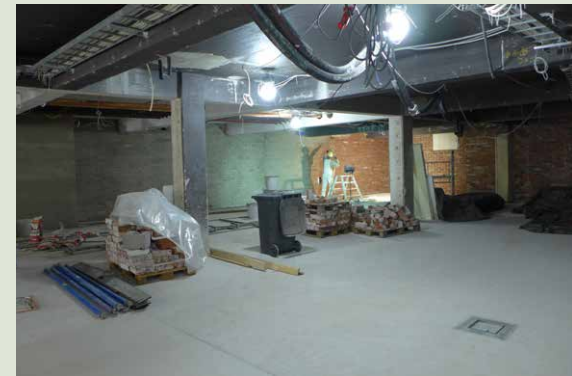
Tiiliseinän slammaaminen eli ohutrappaaminen kesken toisessa kerroksessa.
