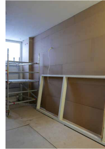
Slammattu seinä on päällystetty uudelleen puukuitulevyllä ja koteloinnit on uusittu.
