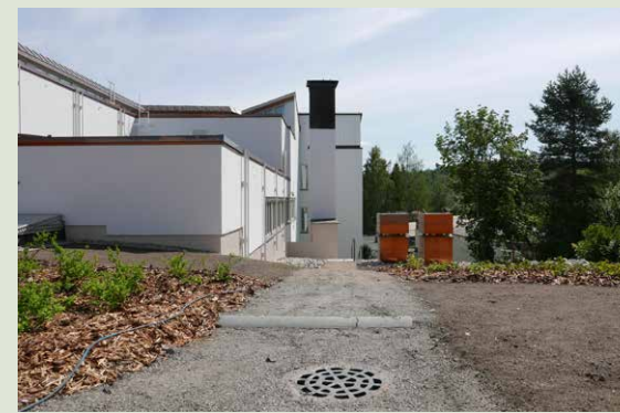
Uusittu kulkureitti iv-konehuoneen yli maastoportaille. Hulevesien ohjausta kaivoihin rinteiden yläpäässä.
