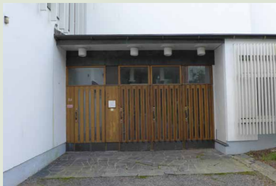
Vanha sisäänkäynti ennen peruskorjausta. Oven yläpuolella lukee "KESKI-SUOMEN MUSEO".
