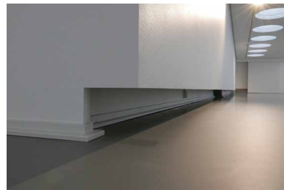
Uuden tekniikkaseinän alaosan porrastus on hieman erilainen kuin aiemmin.
