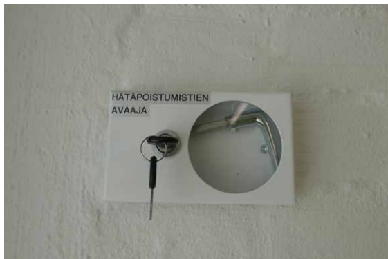
Toimistosiivessä ikkunan saa hätätilanteessa auki sisäpuolelta ikkunan irtopainikkeella.
