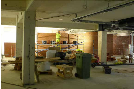
Seinäkkeen muuraus puretun asunnon kohdalla vanhoista punatiilistä.
