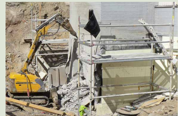
Uutta pysähtymistasoa varten tarvittavan oviaukon avaaminen oli valmistautumista tulevaan.
