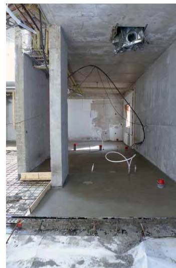
Wc-tilojen kohdalla uusi alapohjalaatta on juuri valettu.
