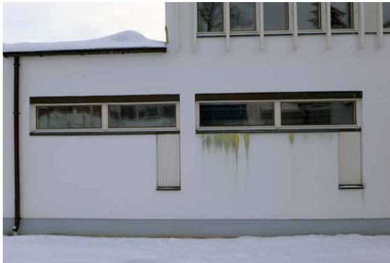
Kahvila ja sen keittiön yläikkunat tuuletusluukkui-neen.
