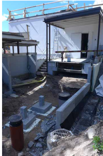
Uusi betonimuuri sekä erikseen valetut jätekatoksen pilarianturat, jotka myöhemmin siirrettiin paikoilleen.
