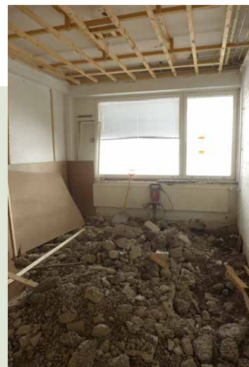
Alapohjan eristekerroksien sekä kipsilevykaton purkamisen (210).
