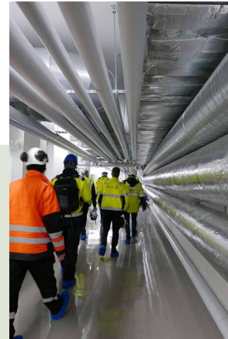
Suunnittelijat ja urakoitsijat matkalla uuteen ilmanvaihdon konehuoneeseen toimintakoepäivänä.
