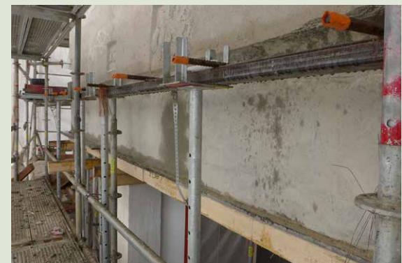
Vaurioitunut leukapalkki korjattiin uudella betonivalulla. Lopuksi pinta rapattiin ja maalattiin.
