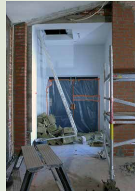
Hissitornin ja vanhan osan karkeasti tehty liittymäkohta purettiin ja rakennettiin uudelleen.
