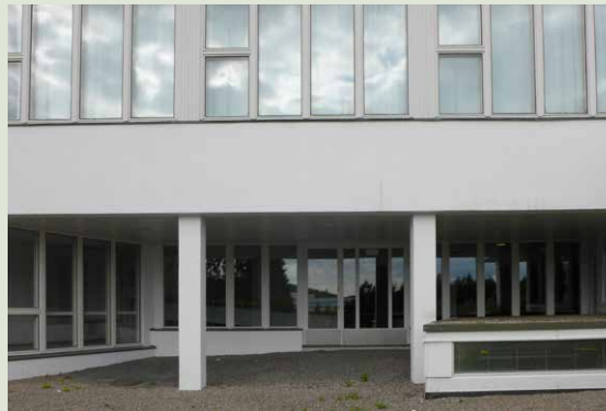
Sisäänveto muuttuu vasemmalla hissikäytävän jatkeeksi ja oikealla on portaikon yläosa ikkunoiineen.
