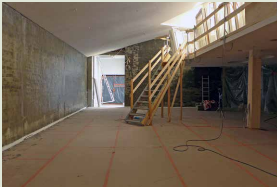
Tiiliseinät on tasoitettu ja niille on tehty tiivistyskäsittely.
