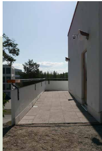
Parveke korjauksen jälkeen.
