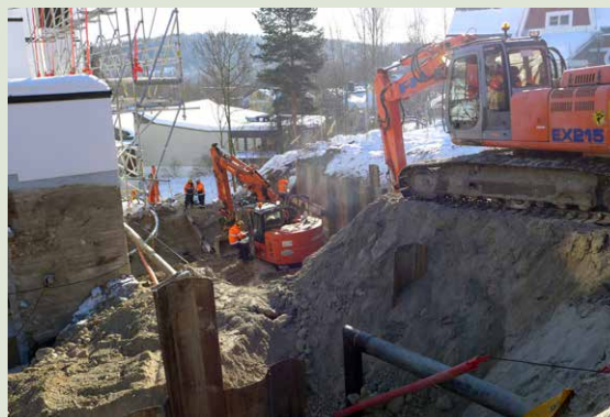
Maankaivuutyöt tulevan iv-konehuoneen ja iv-kaanalin alueella Keskussairaalantien puolella.
