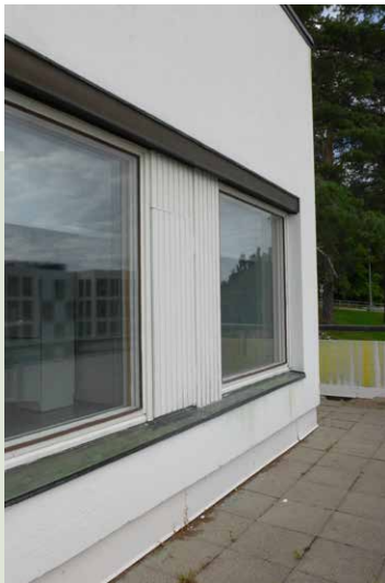
Vanhan osan ikkunoita kahvilan kohdalla ja ikkunoiden välissä paneloitu alue sekä tuuletusikkuna.
