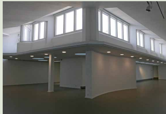
Tilan 401 laattalattian säilyttäminen ei ollut mahdollista. Uusi lattia on vanhojen laattojen väriin sävytetty.
