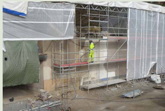
Maalipinnan poistoa märkähiekkapuhalluksella laajennusosan pääsisäänkäynnin vieressä.
