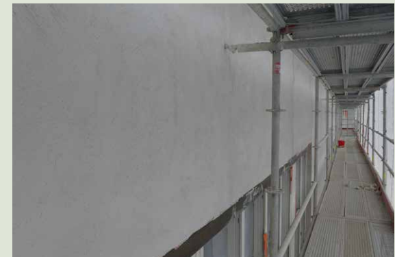
Uudelleen pintarapattua pintaa rakennuksen kaakkoisseinällä.
