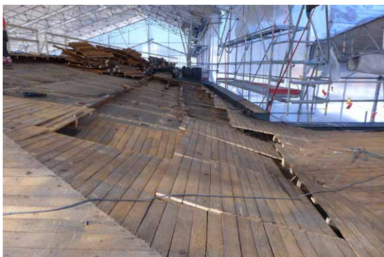
Aluslaudoituksen ja puurakenteiden purkaminen näyttelysalin 401 yläpuolella.
