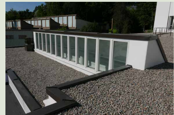
Klerestorioikkuna purku- ja korjaustöiden jälkeen.
