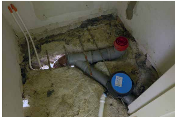
Jotta lattiapinta ei nousisi, oli uusia putkia upotettava kantavaan laattaan ja pujoteltava terästen alle.
