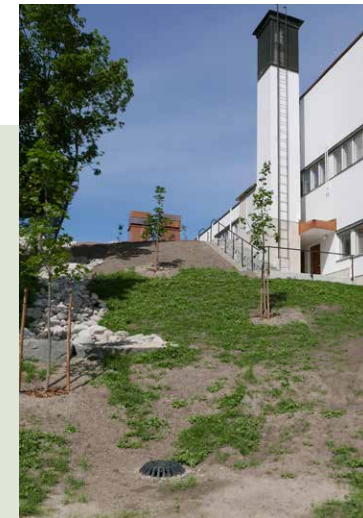
Uusi maastoporrasta ja hulevesipainanne. Takana rinteellä näkyvät konehuoneen poistoilmapiiput.
