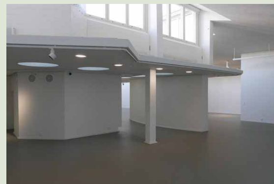
Varaston seinän ilmastoinnin säleikköjen sijainnit ja ulkonäkö muuttuivat. Lattialistat ovat nyt valkoiset.
