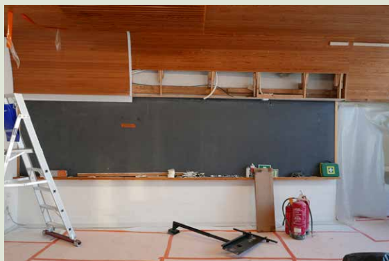
Liitutaulun eteen tulevaa näyttöä varten katon puuritiä jouduttiin hieman purkamaan.
