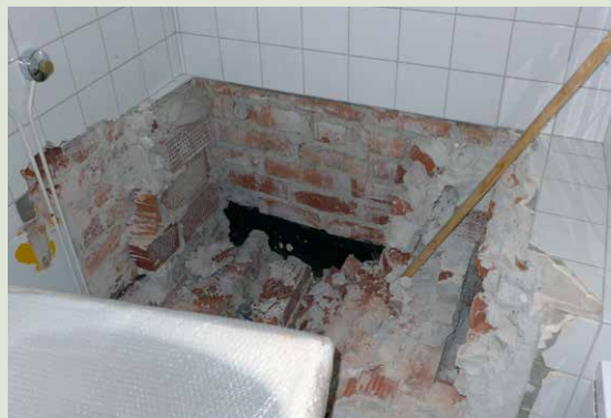
Valurautaisen ammeen ympäröivät rakenteet oli muurattu tiilestä. Alaosassa vedeneristys.
