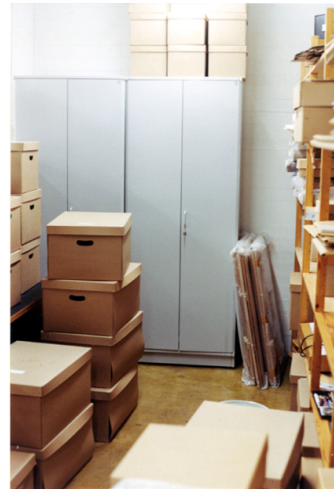
KUVA 26 Kellarisijainnin takia pohjaveden tai lumen sulamisveden aiheuttama ajoittainen korkea kosteus sekä vesivahingot → alimmat pahvilaatit sisältöineen ovat olleet märkiä.
