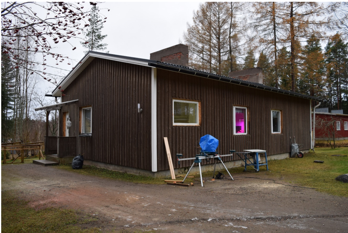
Kuva 12. Au5 Kumpurannantie 75d (Nousiainen 2017)
