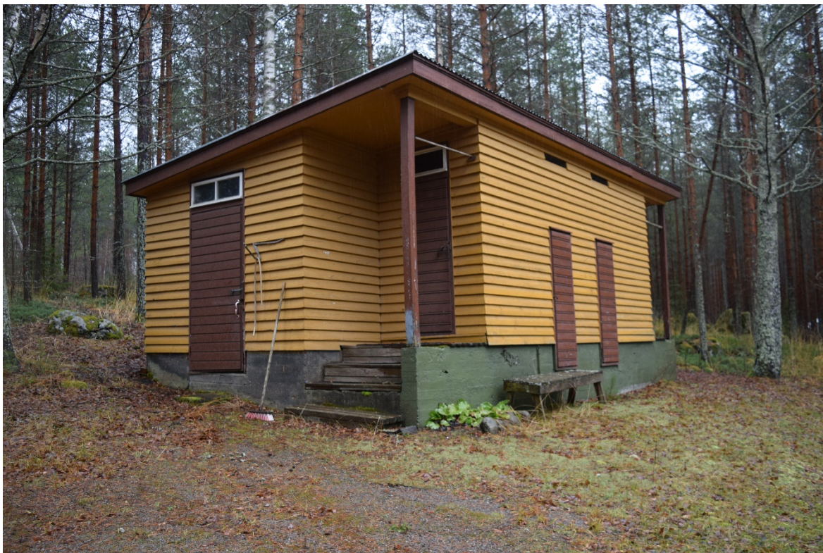
Kuva 16. U2 Kumpurannantie 85c:n ulkohuonerakennus (Nousiainen 2017)
