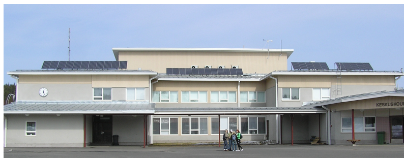
Kuvio 10. Saarijärven koulukeskuksen katolle on asennettu yhteensä 33 aurinkokennoa, jotka on jaettu kolmeen riviin. Paneelit on suunnattu etelään ja niiden kallistuskulma on 40^\circ .
