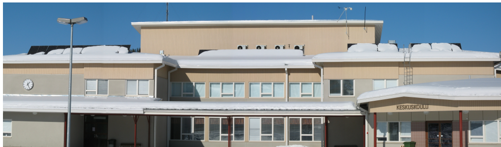
Kuvio 21. Paneelisto on ollut talvella osittain peittyneenä lumen alle, jolloin paneelisto voi muuttaa Auringon säteilytehon vain osittain sähköksi.
