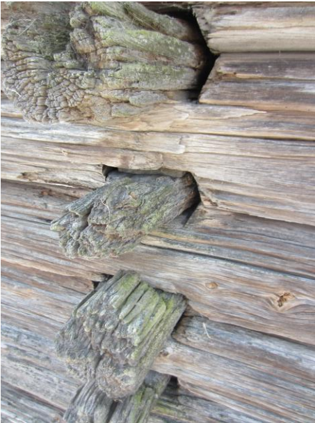
Kuva 12 Riihen väliseinän salvos
