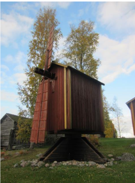
Kuva 47 Museon tuulimylly etelästä kuvattuna
