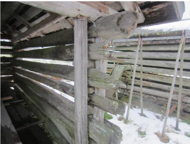
Kuva 54 Suupieliladon ovinurkan seinärakenne
