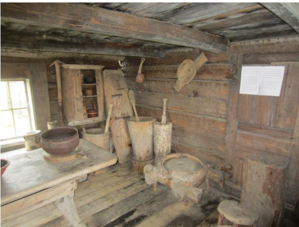
Kuva 4 Savutuvan piiluttua sisäseinää
