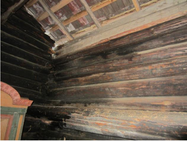
Kuva 16 Riihihuoneen koillisseinän sisäpinta
