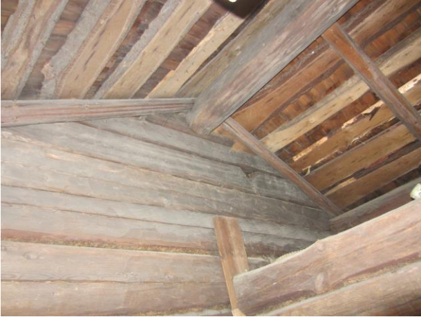
Kuva 23 Saunan porstuan ja kamarin jakavan väliseinän hirsirakenne
