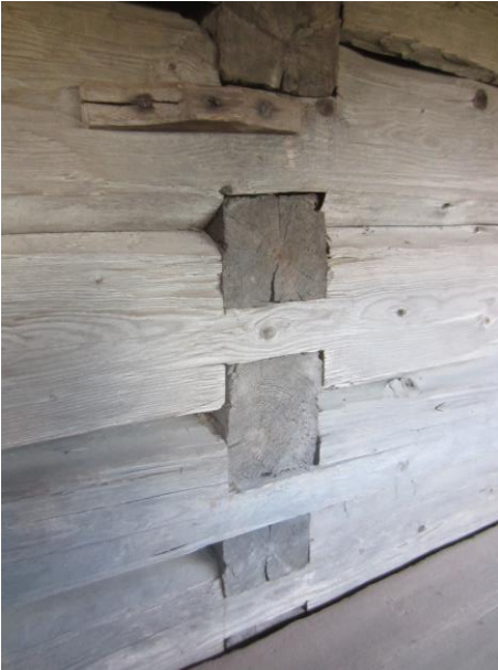
Kuva 35 Luhdin yläkerran huoneita jakavan väliseinän lyhtynurkkia
