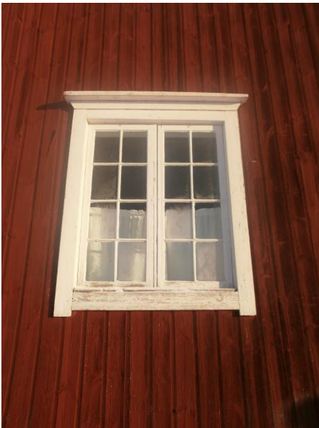
Kuva 45 Alperintuvan 16-ruutuinen lasi-ikkuna
