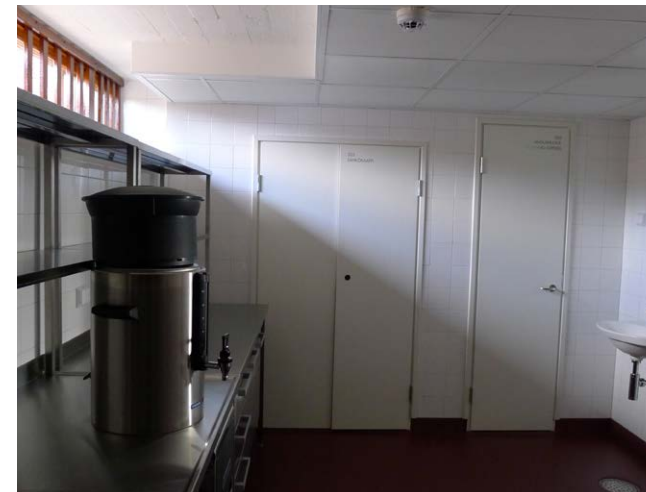
Valmis apukeittiö. Katonrajassa sijaitsevan ikkunan kohdalle ei tullut laskettua alakattoa.
