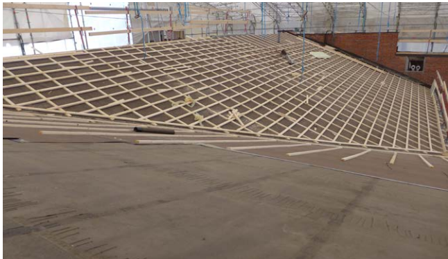
Vanhan huopakatteen päälle tuli uusi huopa ja puurimoitus.
