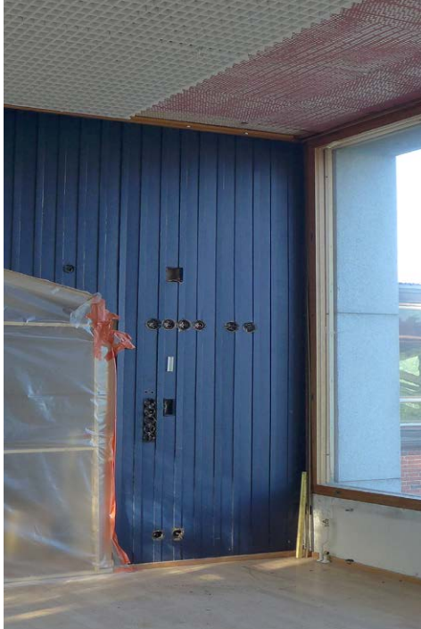
"Sinisen seinän" korjaukset vaiheittain: lähtötilanne, paneelit ja eristeenä olleet lasivillamatot purettuna, uusien spu-eristeiden asennus ja paneelilaudoitus uudelleen asennettuna.
