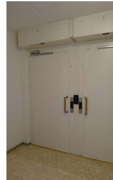
Uudet hissit tarjoilukeittiön paikalle rakennetusta käytävästä katsoen. Lattian laatoitusta paikattiin vanhoilla laatoilla, jotka erottuvat hieman tummuutensa takia.
