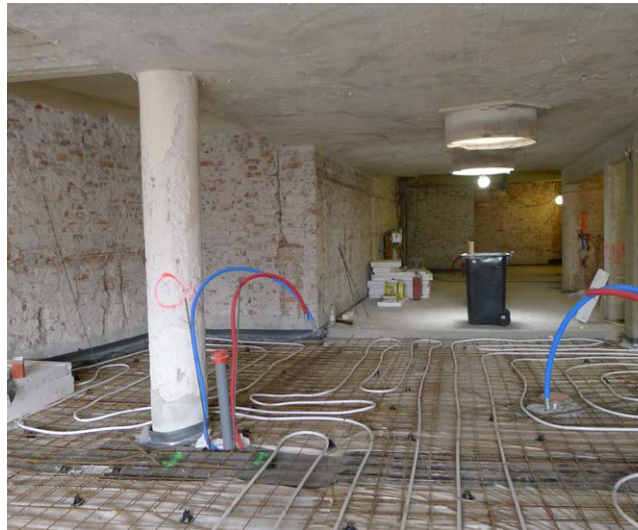
Takana betonilattia on jo valettu, edessä näkyvät raudoitukset sekä valkoiset lattialämmitysputket.
