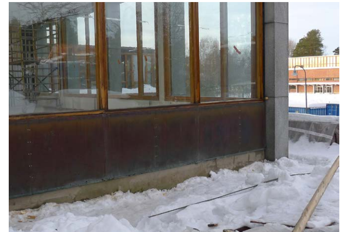
Ulkoseinän kupariverhous on kiinnitetty takaisin seinään.
