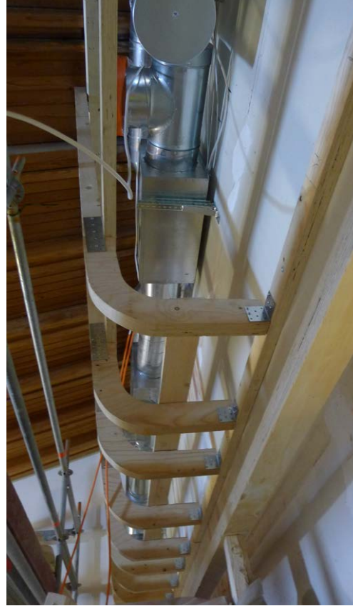
Ilmanvaihdon asennuksia ja kaarevan kotelon runkon puuosien asennusta.
