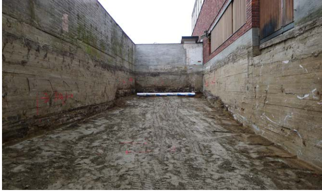
Huoltopiha on tyhjennetty ja maata kaivettu uusia maanalaisia rakennusosia varten.
