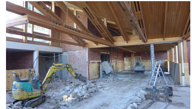
Välipohjan pintabetoni purettiin. Tarjoilualueelle tehtiin uusi erikoisbetonilattia.
