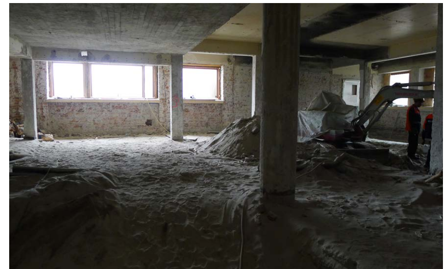
Keittiön pinnat on puhdistettu vanhoista pintakäsittelykerroksista ja liasta hiekkapuhaltamalla.
