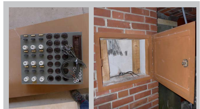
Ruokasalin takaseinällä oli oranssipunaisella maalattu luukku, jonka sisältä paljastui väliaikaisen, pitkään poissa käytöstä olleen "näyttämörakenteen" sähkökeskus lasitettuina sähkökaavioineen. Sähkökeskus ja kaavio on siirretty Yliopiston tiedemuseon kokoelmiin.
