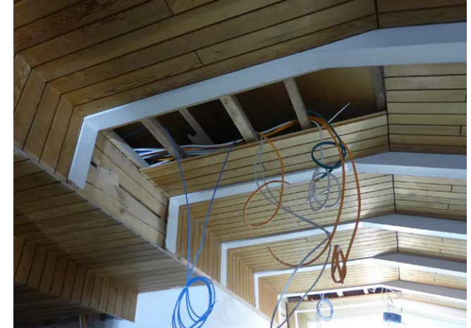
Kattoon sijoitettiin kaapeleita ja asennuksia varten irrotettiin varovasti osa katon paneeleista.
