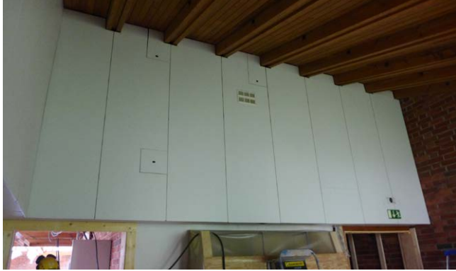
Takan yläpuolella ja kerhuhuoneen puoleisella seinällä oli vuonna 1979 tehdyt ilmanvaihdon koteloinnit.
