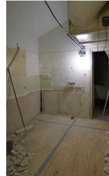
Kolmannen kerroksen tarjoilukeittiön siivouskomerosta oli kulku hissien pyörästöhuoneeseen. Tähän tulivat alla näkyvät uudet hissit.
