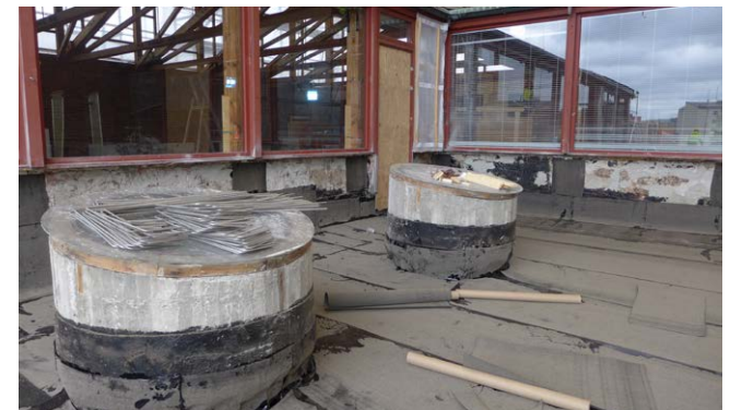
Vanhat rakennekerrokset on purettu ja pihakannen ja seinien uudet vedeneristystyöt ova käynnissä.
