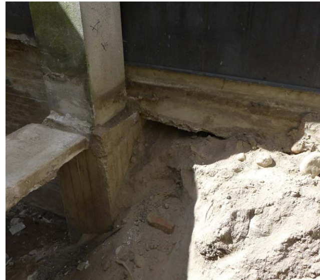
Lyhdyn pilarin ja seinän perustuksia ulkopuolisten kaivuutöiden aikana. Vasemmalla Lyhdyn sisäänkäynnin muurin ja pilarin perustuksen välinen betonipalkki.
