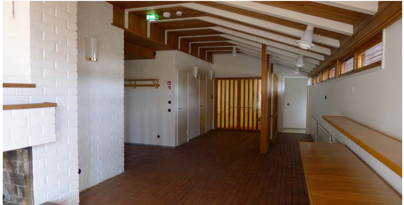
Lyhdyn eteinen peruskorjauksen jälkeen. Muutokset ovat hyvin pieniä: sähköasennuslistoja on poistettu, katkaisijat ja eteisen pieni naulakko on vaihdettu, pintakäsittelyt uusittu tarvittavilta osin.
