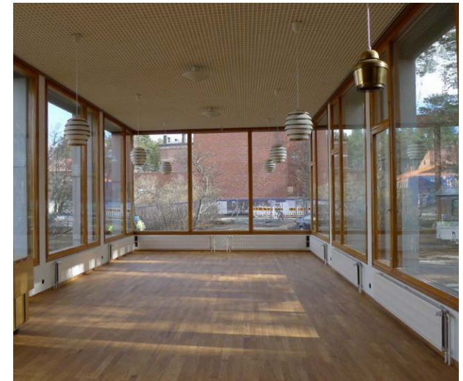
Lyhty peruskorjauksen valmistuttua keväällä 2015. Näkyvimvät muutokset ovat parketti ja korkeammalle ripustetut valaisimet sekä uudet pistorasiat.
