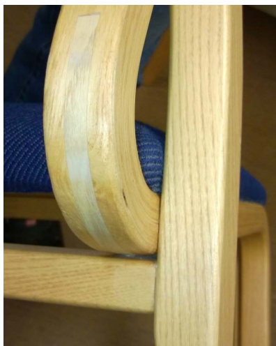
Lyhdyn tuolien korjaustavan mallityö.
