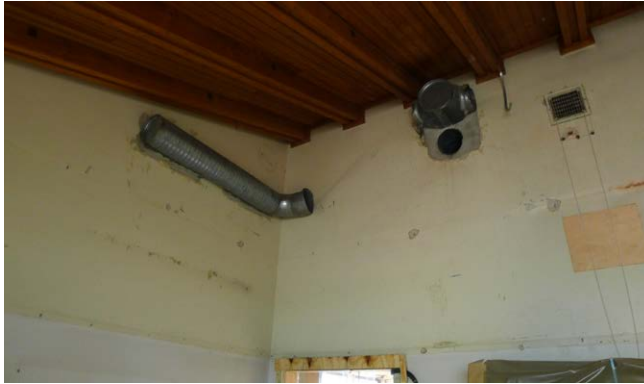
Kerhuhuoneen puolella ilmanvaihdon asennusten aukot seinissä muurattiin umpeen.
