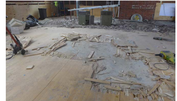
Lattioiden pintamateriaalien eli parketin ja punaisen lattiaaatoituksen purku.
