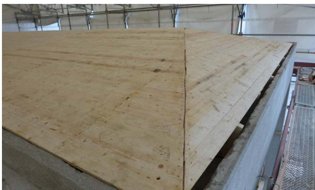
Vesikaton uusi aluslaudoitus.
