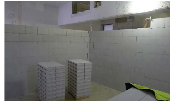
Uusien väliseinien muurausta sosiaalityötilojen alueella.
