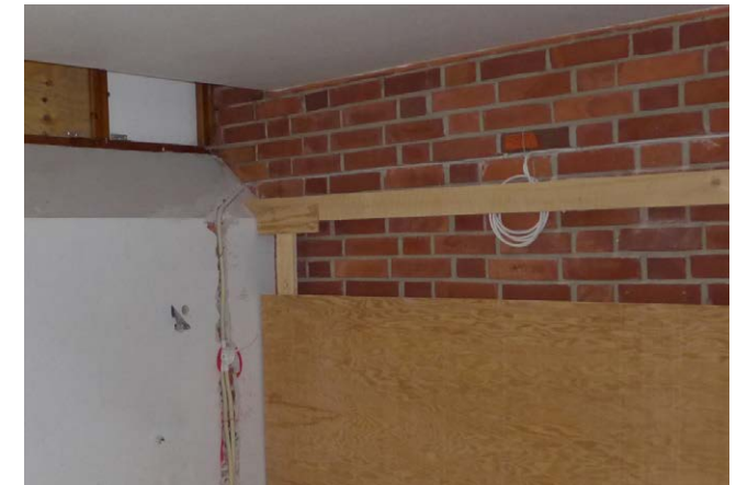
Sähköjohtoja ei asennettu pinta-asennuksina, joten ne joko roilottiin rappaukseen tai sijoitettiin tiilimuurauksen saumoihin.
