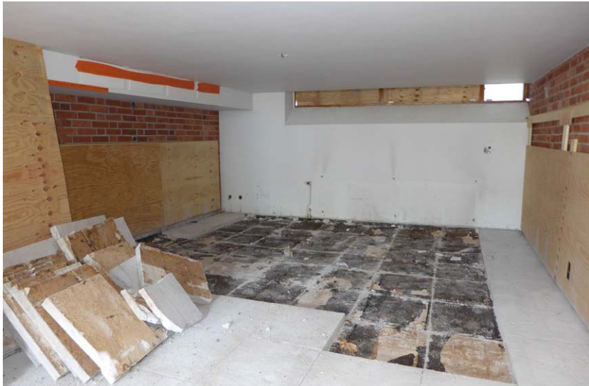
Alapohjarakenteen purkua. Pintabetonin alta paljastunut rakennuspa- peri ja korkkieriste. Takan vieressä purettava IV-kotelo.
