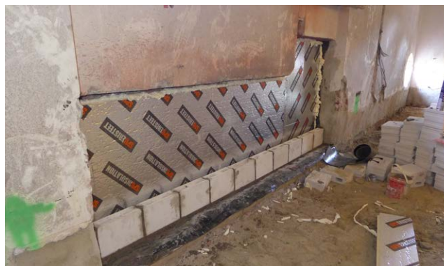
Uusi patterin takainen seinärakenne.
