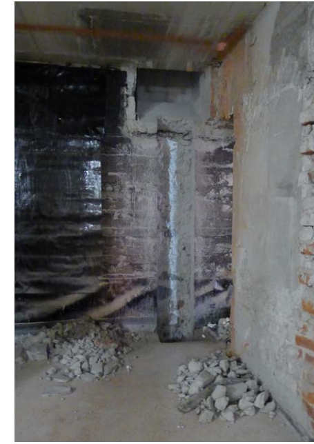
Keittiössä betonisen ilmanvaihdon hormin muutostyöt. Peltikanavien asennusta varten seiä on purettu.
