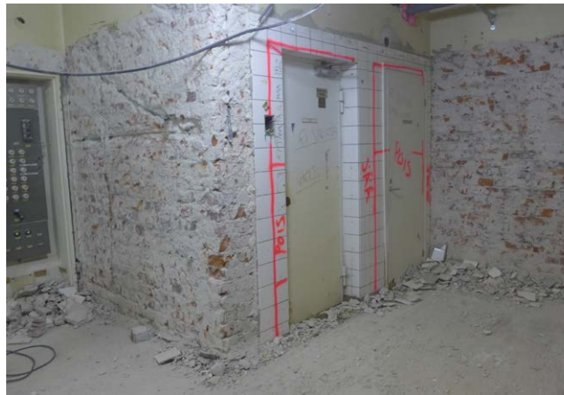
Rakennuksen ainoa hissi ennen peruskorjausta ja viereen tehty siivouskomo keittiössä.
