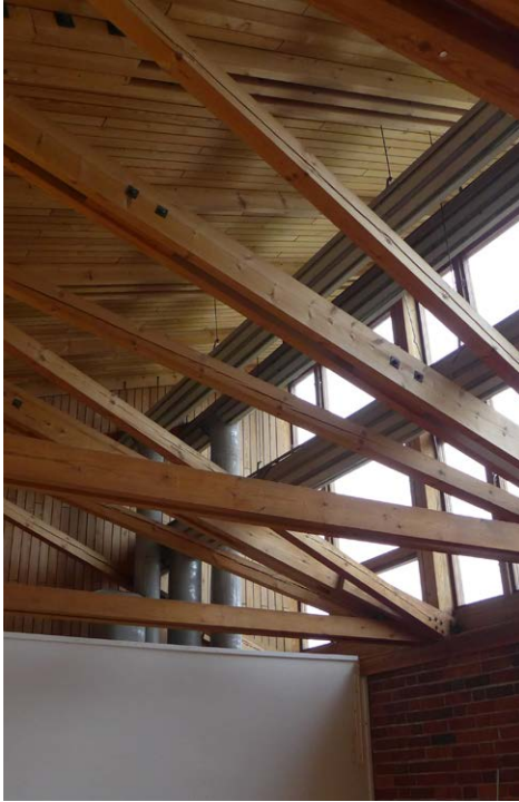
Kattotuolit ja niiden lomassa kulkevat harmaaksi maalatulla puurimoilla verhoillut ilmanvaihtoputket.
