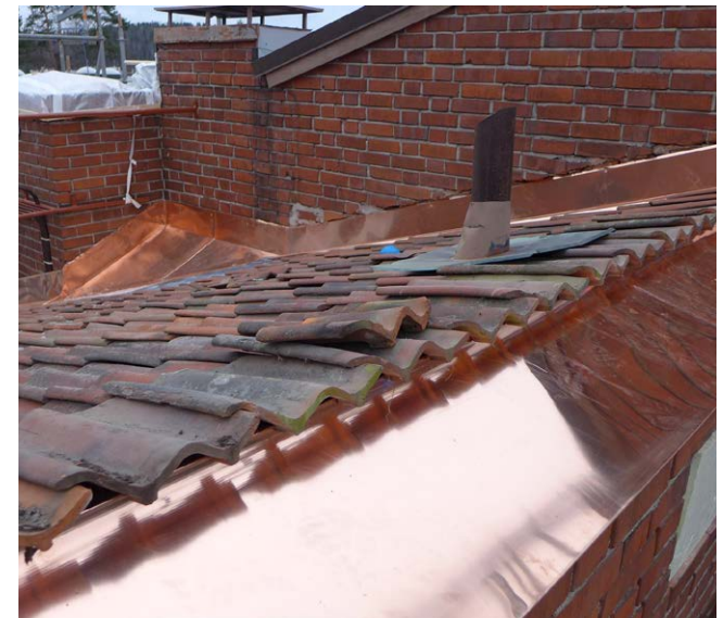
Uudelleen ladottu kate ja uudet kuparipellitykset.
