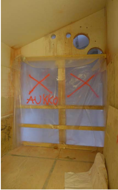
Kalusteet on purettu ja lattiapinnat suojattu. Hissien alueella vanhan hissikuilun rakenteita, väliseiniä ja välipohjia on purettu.
