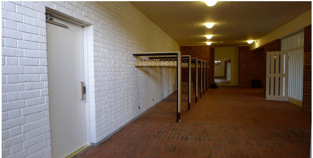
Lozzin eteisaula peruskorjauksen jälkeen. Eripituisten naulakoiden rivi jatkaa vinon seinän linjaa. Vasemmalla uusi hissin ovi.
