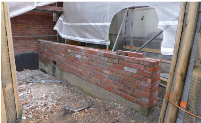
Lyhdyn muuri on korjauksen jälkeen muurattu uudelleen. Kansilaatat ovat vielä asentamatta.
