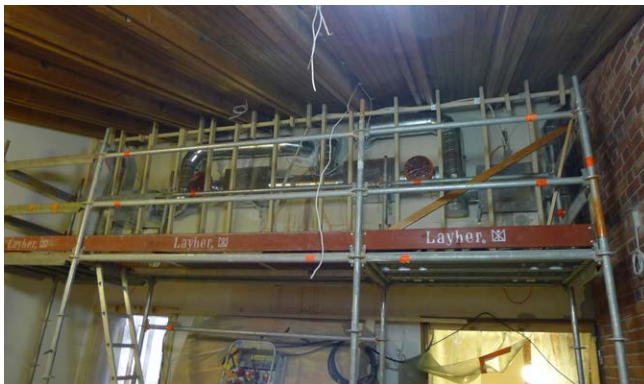
Kaikki uudet IV-asennukset sijoitettiin takan yläpuoliselle seinälle.
