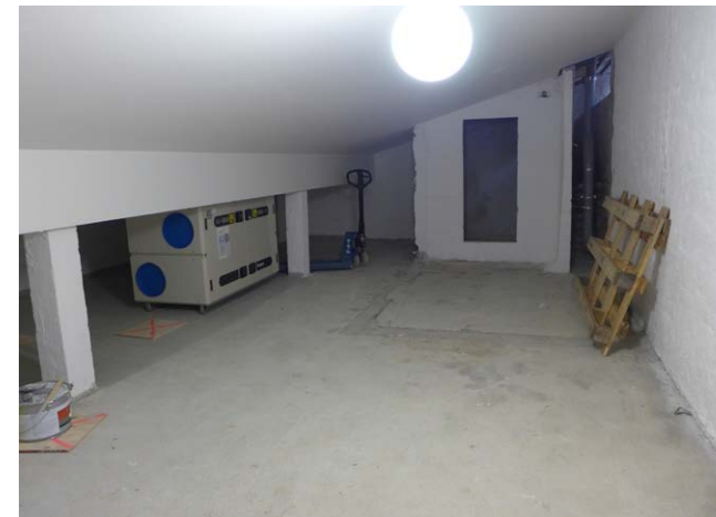
Katto on levytetty ja katto- ja seinäpinnat maalattu. Uusien laitteiden asennus on alkanut.
