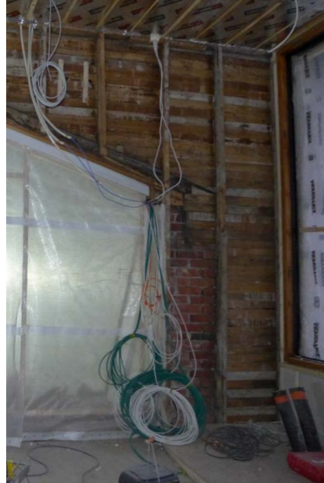
"Sinisen seinän" korjaukset vaiheittain: lähtötilanne, paneelit ja eristeenä olleet lasivillamatot purettuna, uusien spu-eristeiden asennus ja paneelilaudoitus uudelleen asennettuna.
