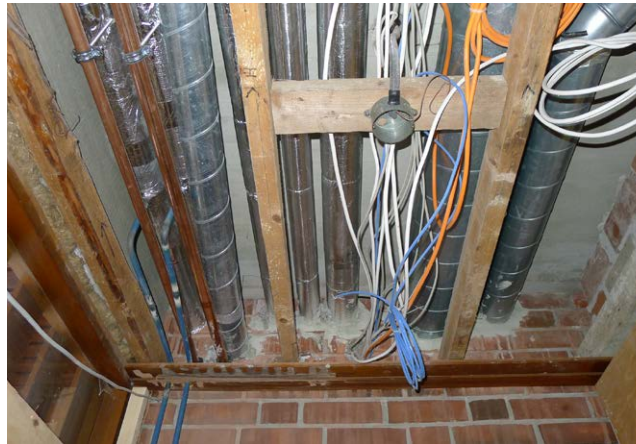
Tuulikaapin katon uudet asennukset.
