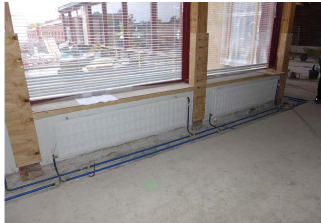
Ruokasalin patterit on kunnostettu ja kiinnitetty takaisin paikoilleen. Uusitut vesiputket on sijoitettu vanhojen putkien mukaisesti upotettuina asennuksina lattian betonivaluun.
