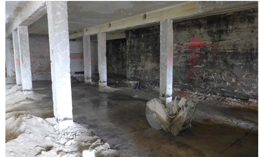
Maanvastaisesta seinästä purettu pinnat aina bitumiselyyn asti ja muiden seinien keraamiset laatat on poistettu. Alapohjan betonilaattaa sahaan kappaleiksi.
