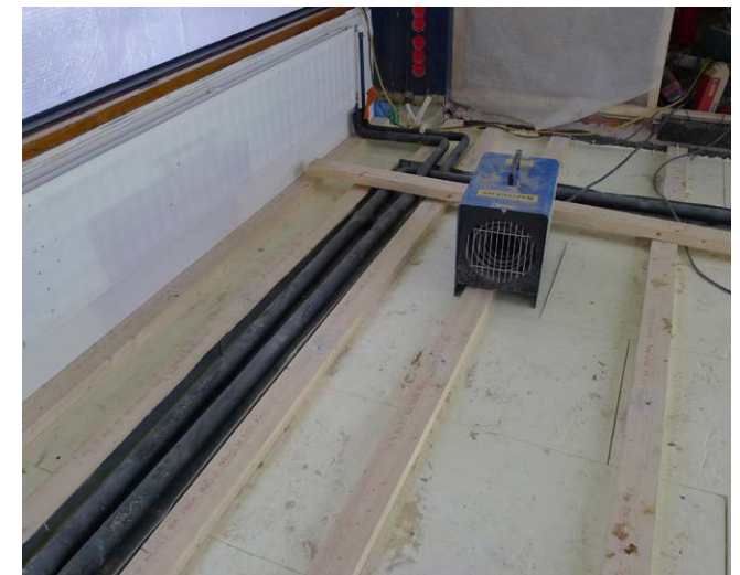
Radiaattoreiden uudet vesiputket sekä alapohjan lämmöneristyslevyjen asennusta.
