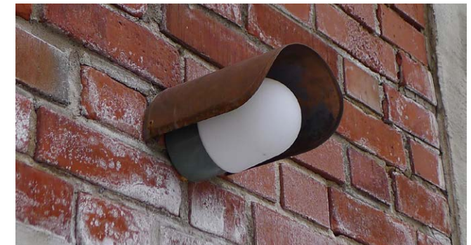
Vanhan valaisimen ja alkuperäisten valaisinten tietojen mukaan tehty uusi ulkovalaisin. Lippa on kuparia.
