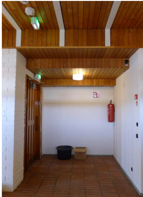
Portaittain kohti sissänkäyntiä laskeutuva katto. Tarkistusluukku toteutettiin kiinnittämällä osa paneeleista ruuveilla, joita ei ole kuvan ottohetkellä vielä ruuvattu kokonaan kiinni.
