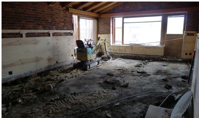
Alapohja on purettu maanvaraiseen betonilaattaan saakka. Ulkoseinustalla kaivetaan IV-kanaalia.
