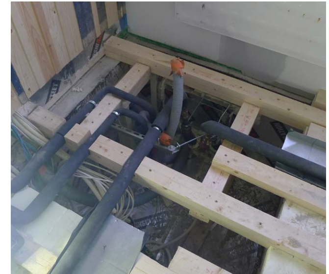
Alapohjaan tehty taloteknisten asennusten kulkureitti urheilukentän puoleisessa kulmassa.
