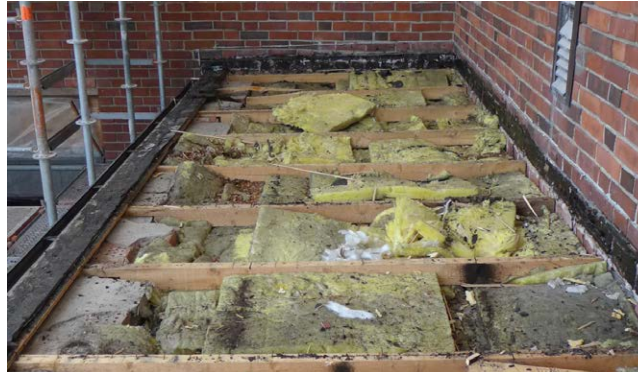
Ruokasalin portaiden yläpuolisen tasakaton eristeet olivat mineraalivillaa.
