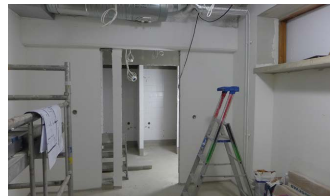
Naisten pukuhuoneen seinien maalaustyöt ja talotekniikan asennukset. Ikkuna on tiivistetty.
