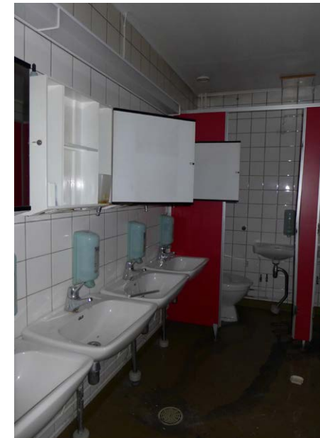
Naisten WC- ja peseytymistiloihin oli tehty edellisen peruskorjauksen jälkeen hyvin vähän muutoksia ja korjauksia. Naisten uusi pesuhuone sijoittui samalle paikalle.
