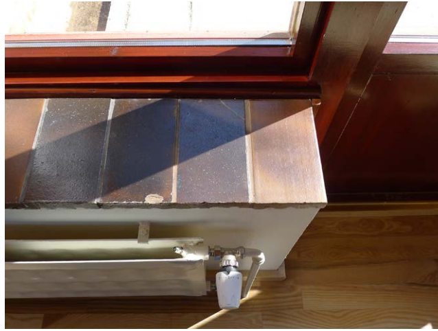
Muutamia rikkoutuneita ikkunapenkien laattoja vaihdettiin säilössä olleisiin vastaavanlaisiin laattoihin.
