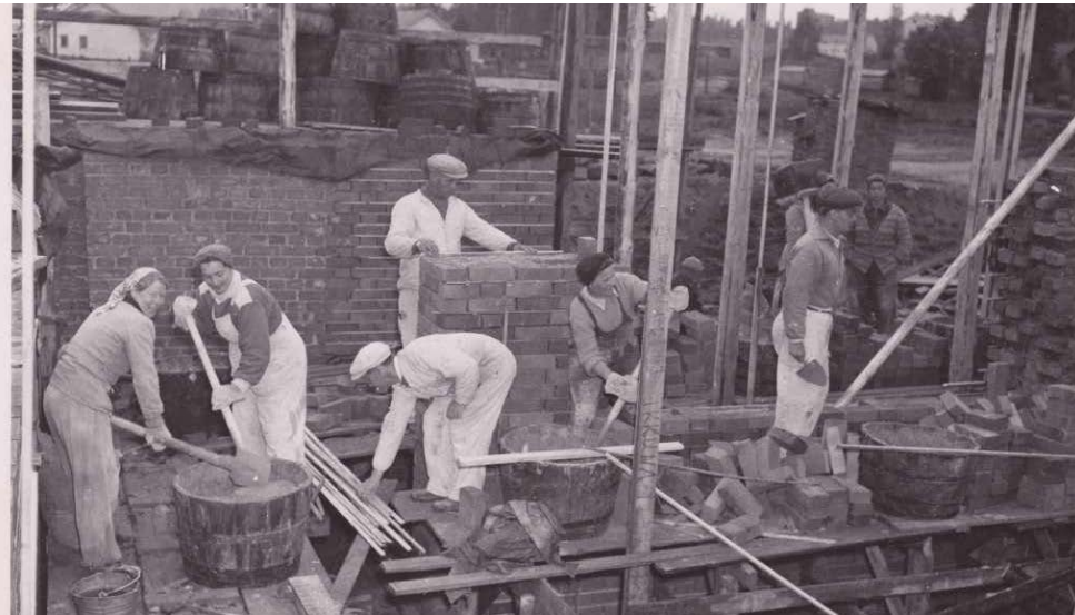
Ravintola- ja asuntolarakennuksen muuraustyöt syksyllä 1952 (JYM K1298:352).
