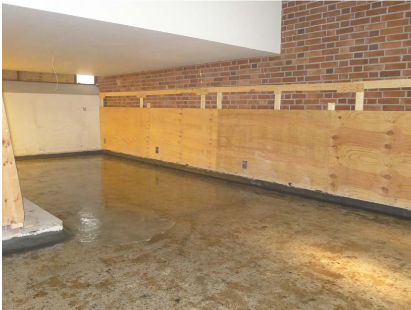
Alapohja on purettu alimpaaseen betonilaattaa asti. Seinän vierustat on tiivistetty ja betoni käsitelty epoksilla. Takkojen edustojen tiilipintoja ei purettu, mutta niiden reunoilta poistettiin korkkia ja ne tiivistettiin.
