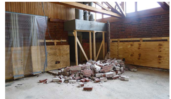
Ruokasalin takaosan muurattu seinäke purettiin, sillä sitä oli siirrettävä hieman kauemmas takaseinästä.
