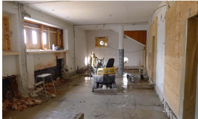
Alapohjan purkutyöt ovat edenneet alimman betonilaatan purkamiseen.
