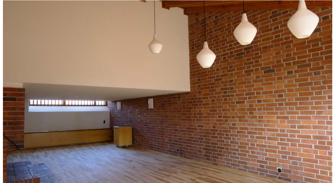
Takkahuone peruskorjauksen jälkeen. Katossa Sipuli-valaisimet. Liikuteltavissa AV-kaapeissa käy- tettiin samaa tammiviilua kuin konvektorikoteloissa.
