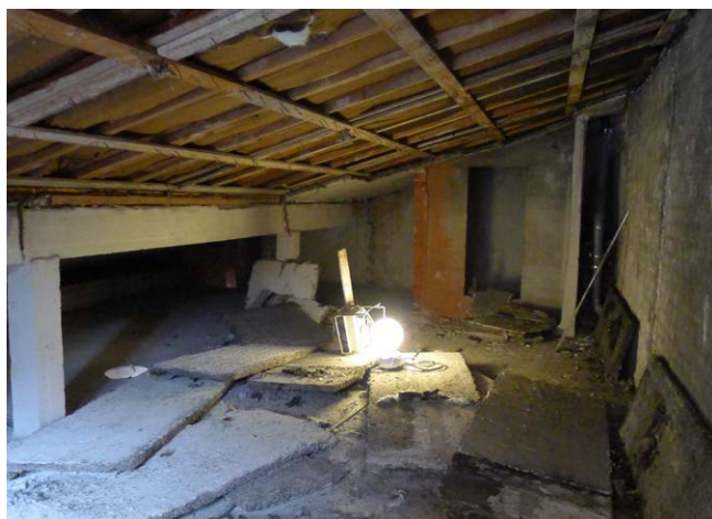
Sementtilastuvillalevyjä poistetaan katosta ja takaa on tullut näkyviin lasivillamatot. Toinen IV-huone on pu- rettu.
