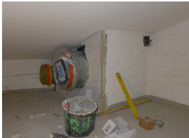
Vanha tiilimuurattu hormi, johon asennettiin uudet poistoilmaputket.
