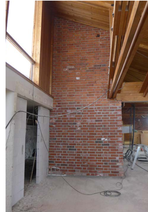
Apukeittiön laajennuksen myötä laatoitettu seinä muurattiin uudelleen vanhoilla tiilillä.
