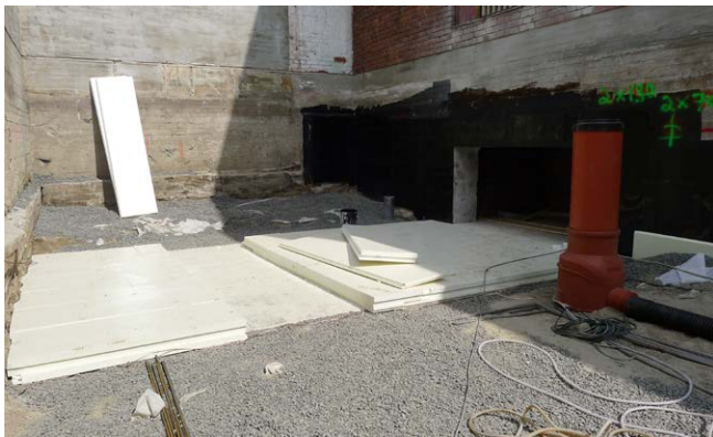
Ilmakanaalin alapohjan lämmöneristys ja perusmuurin vedeneristystöitä.
