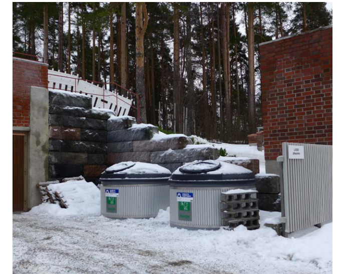
Uusi poistoilmapiippu ja jätekatosten uusi aitaus. Varsinaisen korjauksen jälkeen kivimuurin päälle on lisätty punaiseksi maalattu metallikaide (kuva joulukuusta 2016).
