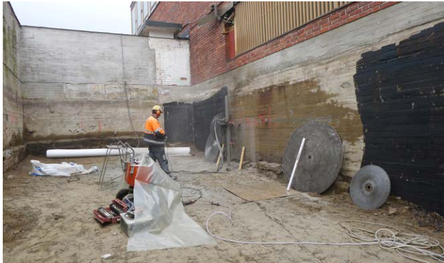
Perusmuuriin sahataan aukkoa ilmakanaalin läpimenoa varten.
