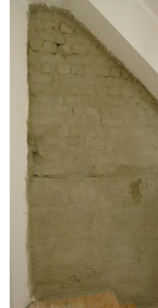
Maanvastaisen seinän pohjustusta ennen rappausta tuotteilla, jotka muodostavat kapillaarikatkon estäen kosteuden imeytymisen maaperästä rakenteisiin ja kosteuden liikkumisen materiaalin huokosissa.
