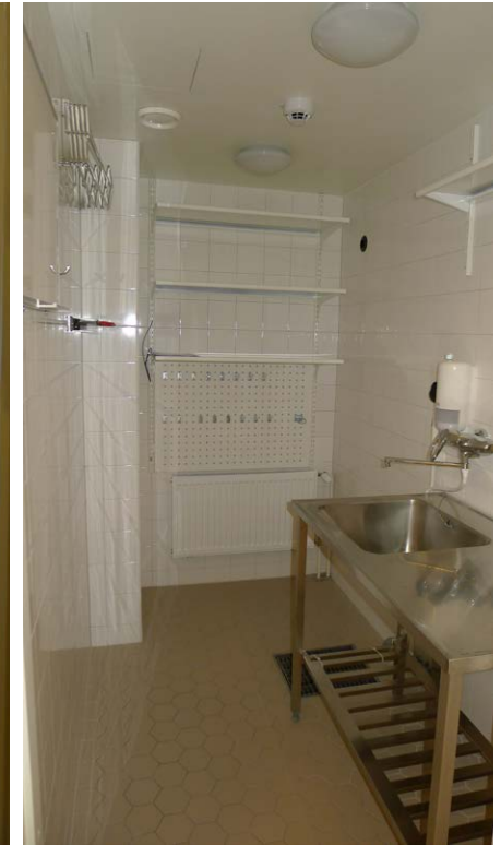
Uusi vesipisteellä varustettu siivoukokero. Uudet laatoitukset ovat mahdollisimman samanlaiset kuin tarjoilukeittiössä ennen oli.
