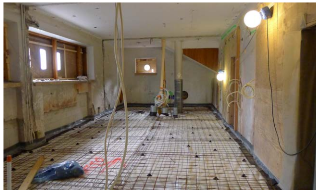
Alapohjan uudet lämmöneristeet ja pintavalun raudotukset tekeillä.
