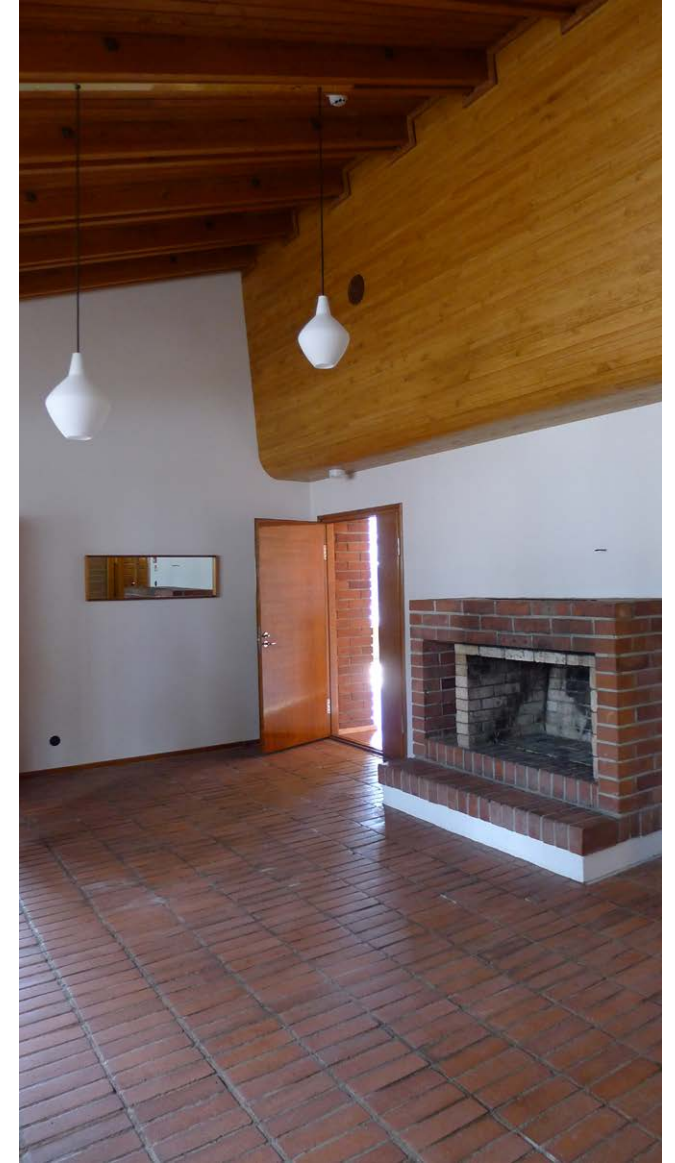
Peruskorjauksen valmistuttua. Käytöstä poistettu takka jätettiin purkamatta ja sen yläpuolella on uusi IV-kotelo.
