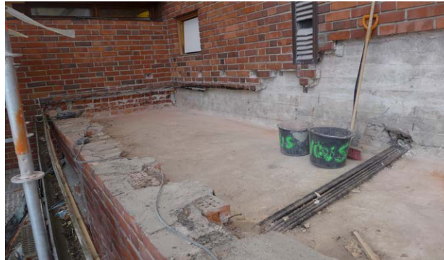
Tasakatalta on poistettu vanha kate, eristekerrokset ja koolaukset.
