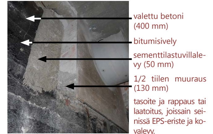
Sementtilastuvillalevyllä eristetty seinärakenne (keittiön seinä).
