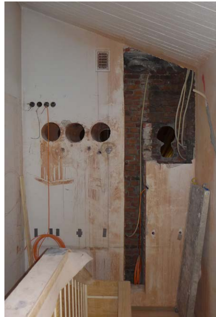
Portaan C puolella kolmannessa kerroksessa rakennuksen vanhoja tiilimuurattuja hormoneja on aukaistu puhdistusta ja uusien peltikanavien asentamista varten. Seinän yläosassa alkuperäinen poistoilmasäleikkö.
