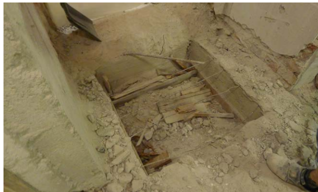
Purkutöissä keittiön lattiasta löydettiin 1970-luvulla puretun ruokahissin rakenteita.
