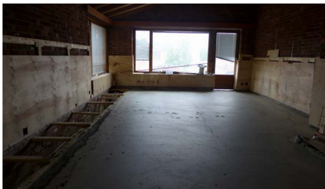
Pintalaatta on valettu uudelleen uusien veden- ja lämmönesteiden päälle. Vasemmalla valettu kanaali.
