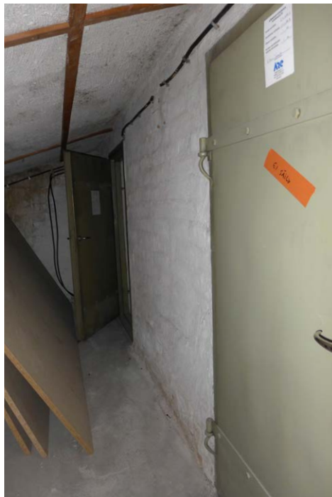
Alkuperäisten IV-huoneiden vihertävät metalliovet.
