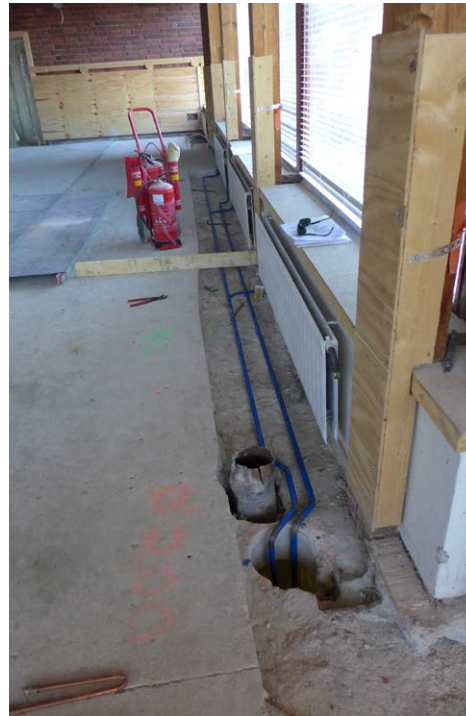
Pattereiden uudet vesiputket ja lattiassa osa poistettavaa ilmastointiputkea.
