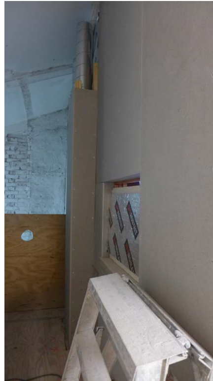
Seinän ja ilmanvaihdon asennusten koteloiden levytykset tekeillä. Takana näkyy pohjamaalattu hissikuilu, josta puretu loput väliseinät.
