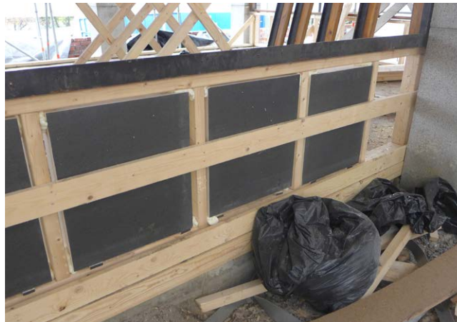
Uusi palosuojattu eristelevy rakennuksen ulkopuolelta kuvattuna.
