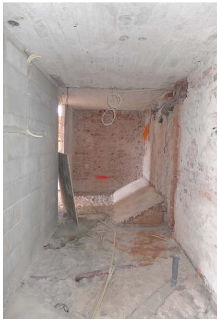
Tilan pinnoista on poistettu laatoitukset, alakatot ja maalipinnat. Osin vinolattiainen laajennus portaikon kohdalla jätettiin purkamatta. Hissikuilun laajentaminen kavensi tilaa huomattavasti.
