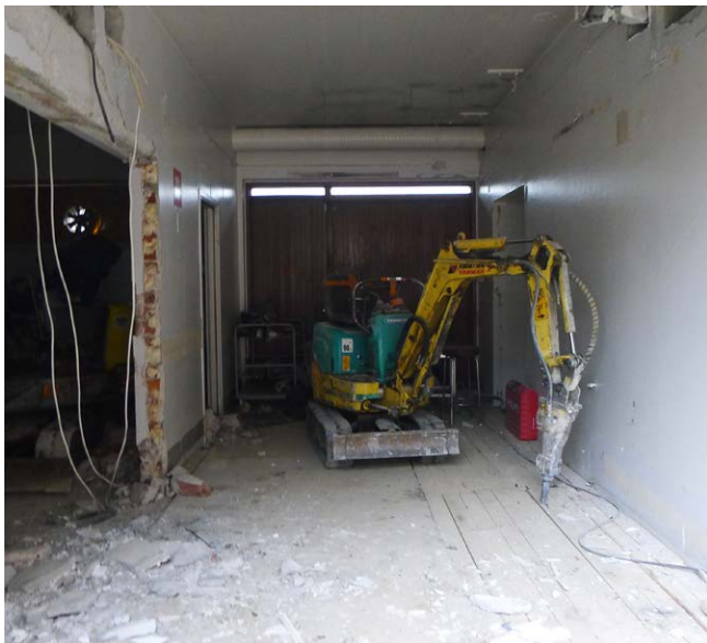
Huoltokäytävä ja sosiaalityötilojen väliseinäpurut. Takana näkyy vanha pariovi huoltopihalle.
