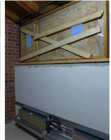
Huoneen molempiin pätyihin tuli konvektorit.
