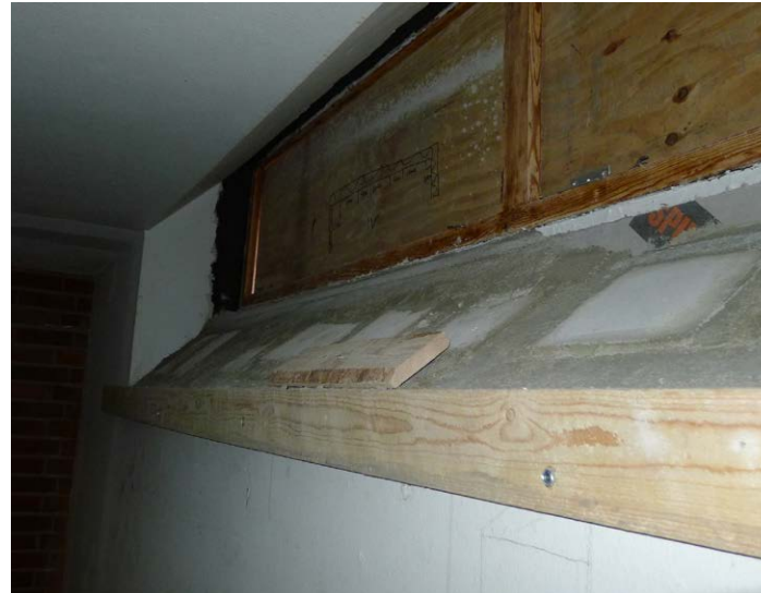
Viisto ikkunapenkki purettiin ja veden ja lämmöneristeet vaihdettiin ja penkki muurattiin uudelleen.
