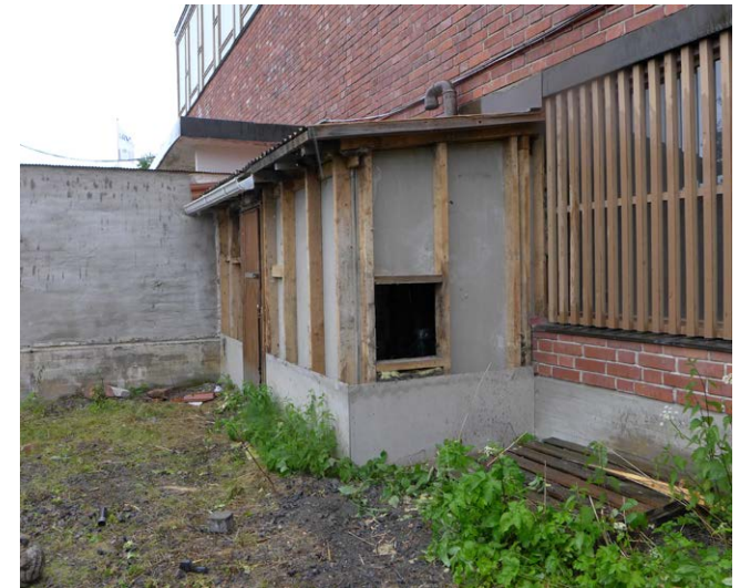
Pihan kulmauksessa olleen jäädytinkompressorin tilan vuorauksen purku.
