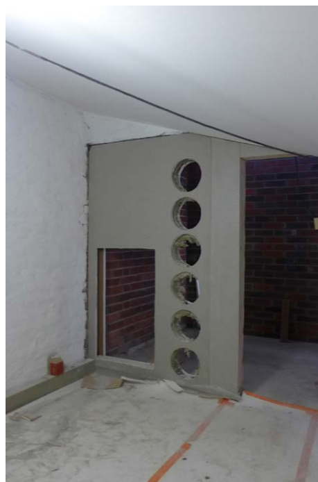
Ruokasalin puoleinen uusi seinärakenne ja ilmanvaihtolaitteiden läpiviennit.
