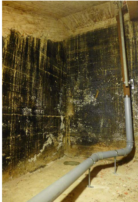
Muottilaudat on poistettu portaiden alta. Tilan viemäriputkesta osa on vaihdettu uuteen ja vanhojen osien sisäpinnat on pinnoitettu ruiskuvalutekniikalla.
