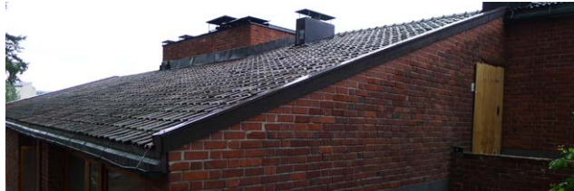
Räystään korotus purettiin ja toteutettiin lähempänä alkuperäistä ilmettä olevalla rakenteella.
