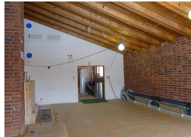
Suutinkonvektoreja asennetaan. Seinällä näkyvät vanhat, umpeenmuuratut ilmanvaihdon läpiviennit ja uudet poistoilmaputket.
