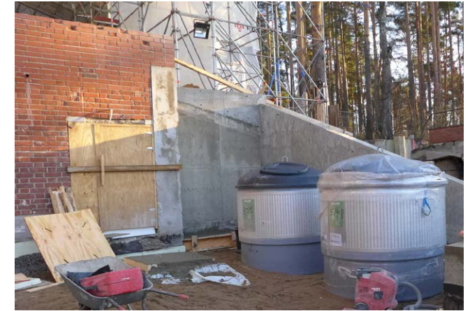
Uusi teräsbetonimuri lastauspihalla.
