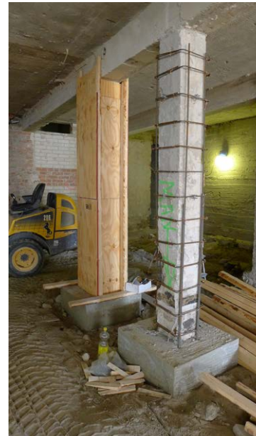
Keittiön pilareiden mantteloiminen eli vahvistaminen.
