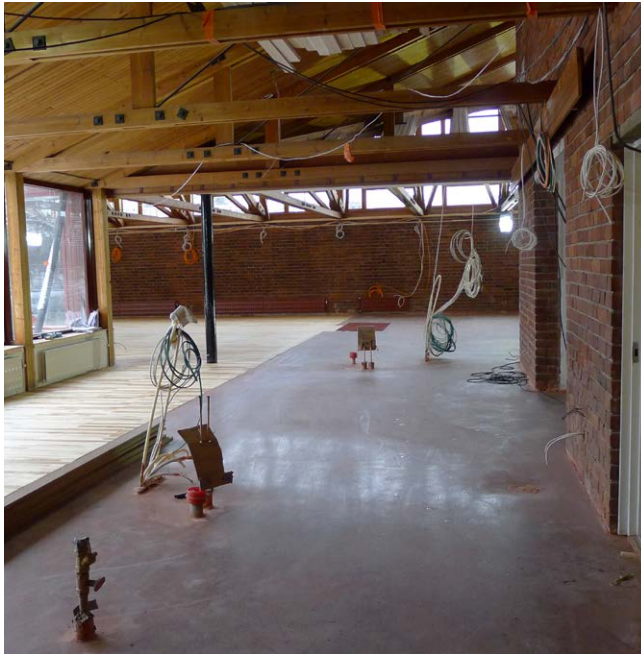
Uuden erikoisbetonilattian väriksi valittiin punainen ja kiviaines on mustaa.
