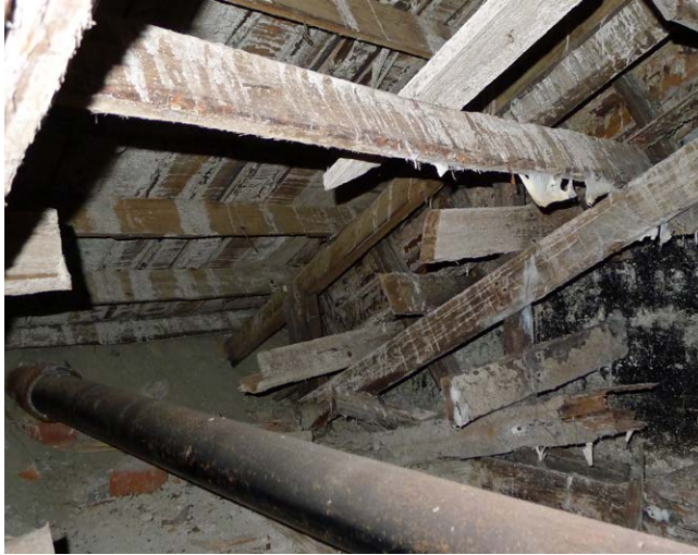
Portaiden alla umpiotilassa olevat muottilaudat ja vanha viemäriputki.
