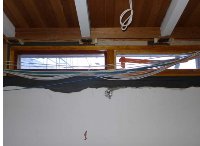
Ikkunoiden karmien tiivistykset, uusi sähköasennuksia ja osittain purettu puukotelo.
