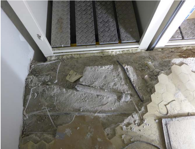
Lattiaklinkereitä purettiin ehjänä hissien edustalta. Alla oli alkuperäisiä putkiasennuksia. Lattia tasauksen jälkeen se laatoitettiin vanhoilla laatoilla.
