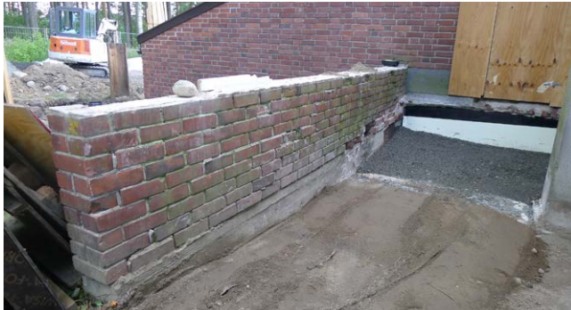
Muuri ennen korjaamista.
