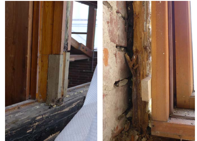
Vasemmalla: ruokasalin koillisenpuoleisen ikkunan puupaikka.
