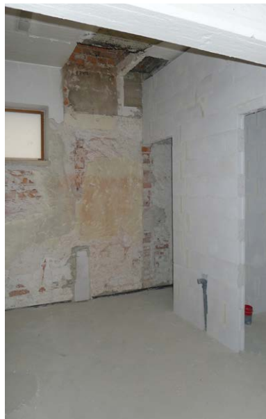
Miesten sosiaalityötilojen uudet väliseinämuuraukset. Kattossa vanhan muuratun poistoilmapiipun hormit.
