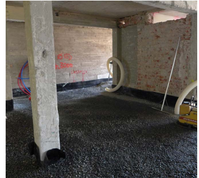
Sepelitäyttö, johon on upotettu radon-putket.
