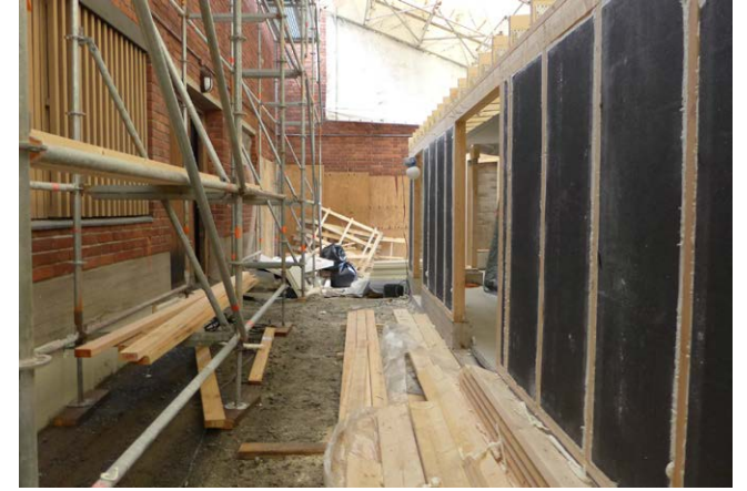
Huoltopihan uusien rakennusten ulkoseinien lämmöneristystyöt.
