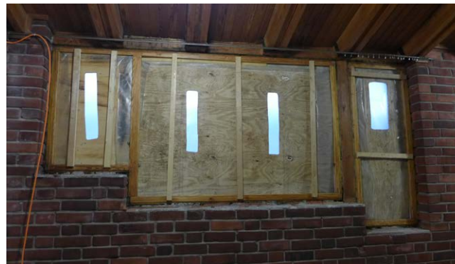
Aulan ikkunoiden karmien kunnostus ja ikkunan rakenteiden tiivistystyöt.
