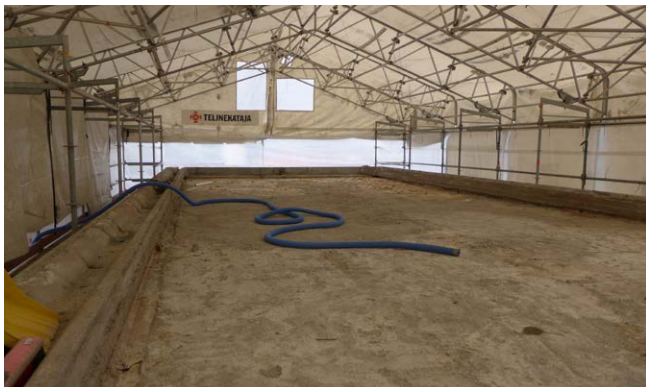
Vesikatteen rakenteet on purettu. Pitkillä sivuilla näkyvät betoniset räystäskourut.
