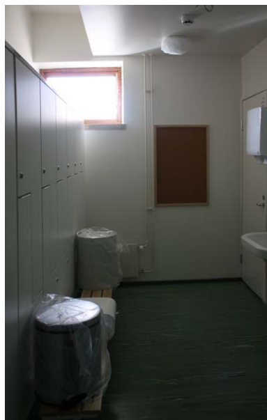
Miesten valmis pukuhuone. Katon poistoilmapiipun kohdalla on uudet asennukset ja levytetty alakatto.
