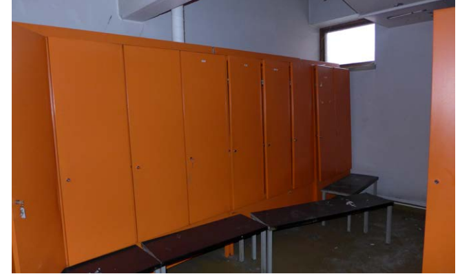
Naisten pukuhuone oli peruskorjauksen alkaessa 1970-luvun asussa. Korjauksessa sen paikalle tuli miesten pukuhuone ja peseytymistilat.
