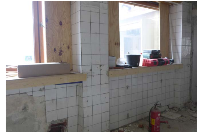
Keittiön seinän purettavat keraamiset laatoitukset ja ikkunapenkkin suojaukset.
