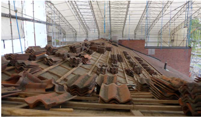
Tiiliä puretaan katoilta. Alla 1990-luvulla tehty rimoitus ja huopakate.
