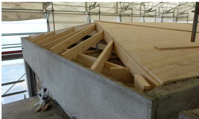
Vesikaton uusi puurunko on valmis ja aluslaudoitus kesken.
