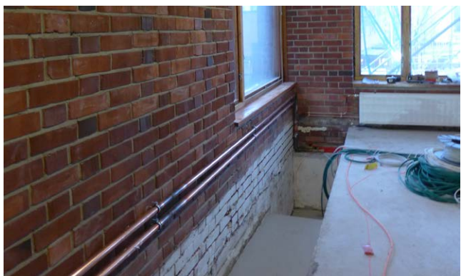
Kanaalin seinämät on pohjamaalattu ja kanavan läpiviennin tekoa valmistellaan.
