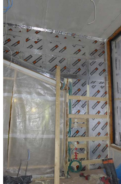
"Sinisen seinän" korjaukset vaiheittain: lähtötilanne, paneelit ja eristeenä olleet lasivillamatot purettuna, uusien spu-eristeiden asennus ja paneelilaudoitus uudelleen asennettuna.
