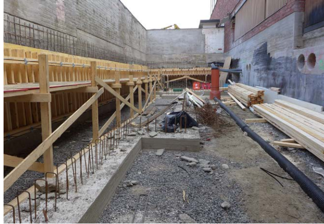
Konehuoneen ja muiden huoltopihan uusien tilojen betonirakenteiden valutyöt ovat käynnissä.
