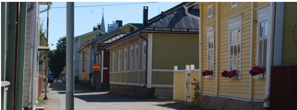
Kuva 46. Keskellä olevan vihreän talon paikalta purettiin huonokuntoinen asuinrakennus, vanhat sokkelikivet hyödynnettiin uuden rakennuksen perustuksissa. Uudisrakennuksen piha on asfaltoitu.
