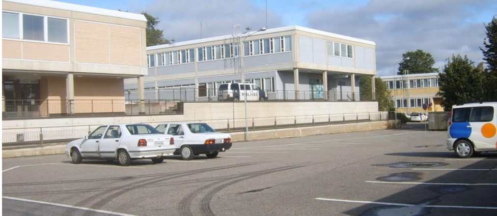
Kuva 34. Kuvan virastotalot ja parkkipaikka rakennettiin keskustan, vuonna 1975 valmistuneen asema-kaavan mukaisesti entiseen puutalokortteliin. (Kuva Liisukka Oksa 2014).
