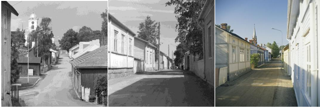
Kuvat 7. A, B ja C. Kuvassa A on Aitakatua kuvattuna eteläsuunnasta kohti pohjoista. B Kuvassa on näkymä Koulukadulta Pohjapäähän. Vasemmalla, edessä oleva rakennus on purettu vuonna 2005 joulukuussa. C Kuvassa Eteläpäässä oleva kadun osa (Itäinen Pitkäkatu) kuvattuna etelästä kohti pohjoista. (Kuvat kuuluvat Teuvo Kanervan vuonna 1981 kuvaamaan puukaupunkisarjaan. MV. (finna). Kuvausajankohtana useimmat kaduista olivat vielä hiekkateitä.
