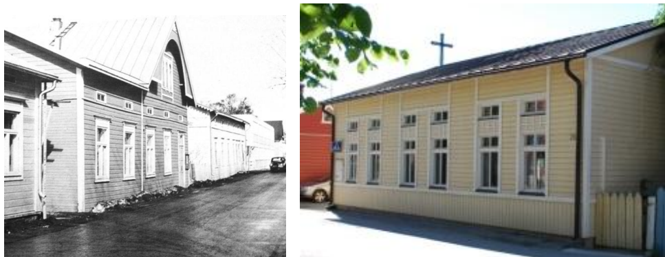
Kuvat 39. A ja B. Kuvapari rakennusten ulkonäön muuttumisesta uudisrakentamisen myötä. Kuvan A keskellä on vanha rakennus ja uusi asfaltti. (Kuva Maire Mattinen, 1985) Läntinen Pitkäkatu 29. Kuvassa B on samalla paikalla oleva seurakunnan uudisrakennus vuodelta 1986. (Kuva Liisukka Oksa 2015).
