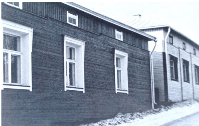
Kuva 27. Energiakorjauksia Koulukadulla. Julkisivuissa on tapahtunut muodonmuutos, joka on näkyvissä syvennyksissä olevista ikkunoista sekä laudoituksen eleettömyydessä. Lämmön karkaaminen on estetty laudoituksen alla olevalla paksulla eristekerroksella. (Kuva. Maire Mattien 1985 Puukaupunkien suojeleminen).
