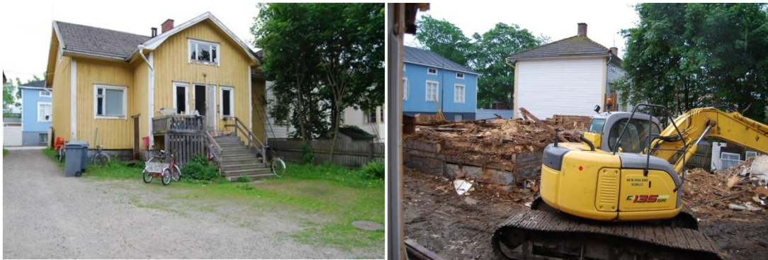
Kuva 35. 1950-luvulla modernisoitu, vuonna 1831 rakennettu, rungoltaan moitteettomassa kunnossa ollut hirsirakennus purettiin vuonna 2012 heinäkuussa uudisrakentamisen vuoksi. Rakennuksessa asuttiin vielä keväällä 2012. Samalta tontilta purettiin lisäksi vuonna 1842 rakennettu ja yhä asuttu kulmatalo sekä pitkä hirsirakenteinen ulkorakennusrivi. ( Kuvat Liisukka Oksa 2012).
