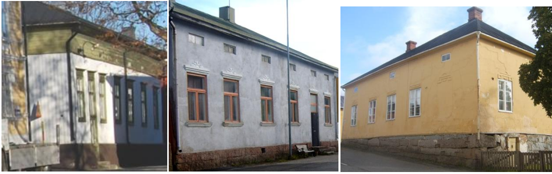
Kuvat 48. A, B ja C, Kuvassa A Felenin talon pitkän julkisivun säilynyt rappaus, Rantakatu. Kuvassa B on Stendahlin talon pitkän julkisivun säilynyt rappaus, Läntinen Pitkätie ja kuvassa C ”Pupulan” vanha rappaus ennen muutosta. Koulukadun ja Läntisen Pitkätien kulma. (Kuvat Liisukka Oksa 2013)
