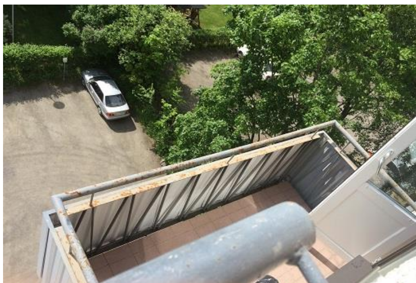
Alkuperäiset pinnakaiteet ovat säilyneet myöhemmässä vaiheessa asennetun profiilipellityksen taustalla.
