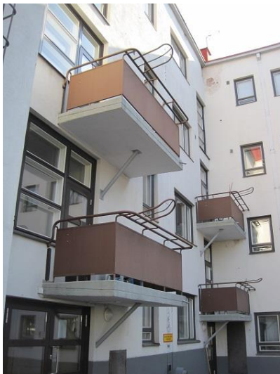
Sisäpihan puoleiset puhdistusparvekkeet Hämäläisen funktionalistista tyyliä edustavassa asuinkerrostalossa. Parvekkeissa rakennusajankohdalle tyypilliset teräspeltikaiteet. Vapaudenkatu 79 (1940).
