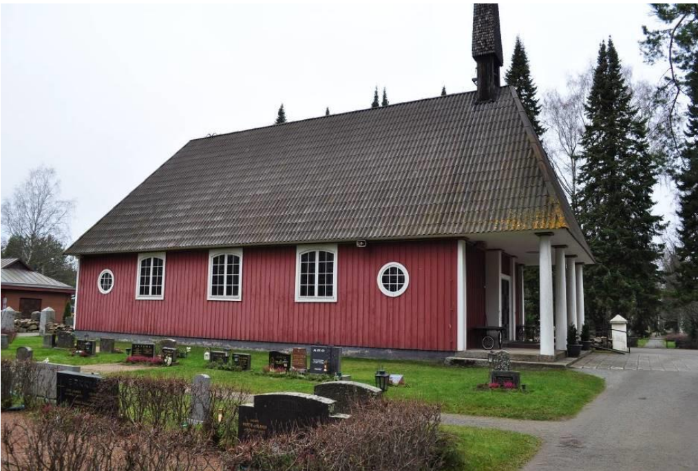
Hautausmaan puoleinen julkisivu.
