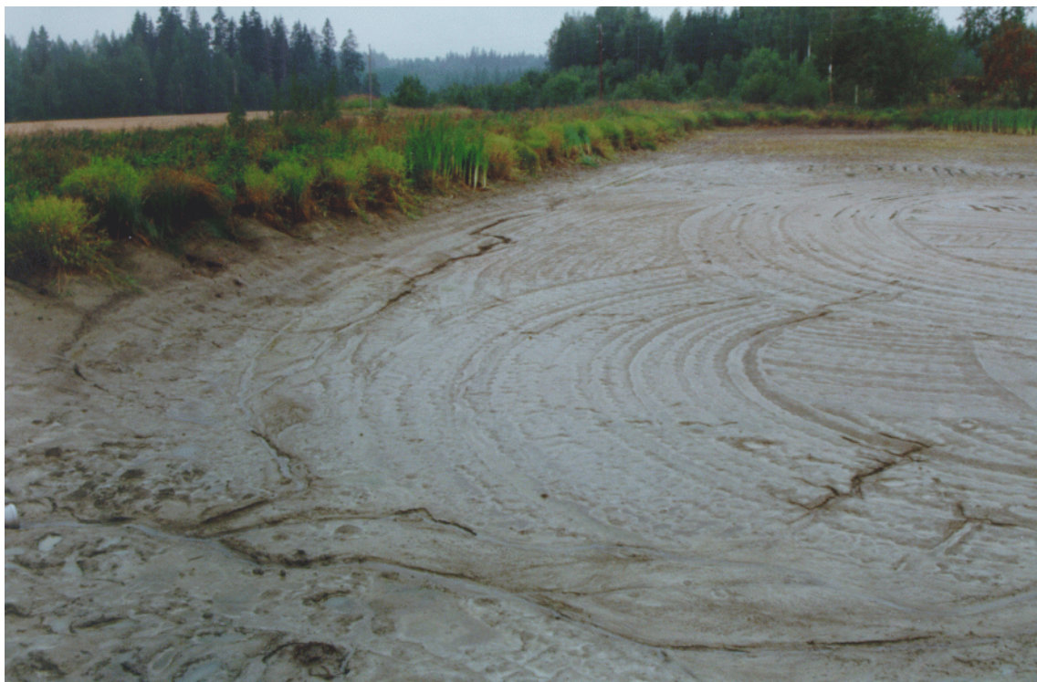
Kuva 17. Altaan ollessa tyhjillään voidaan pohjalta poistaa sinne kertynyt ylimääräinen orgaaninen aines sekä vesikasvillisuus.
