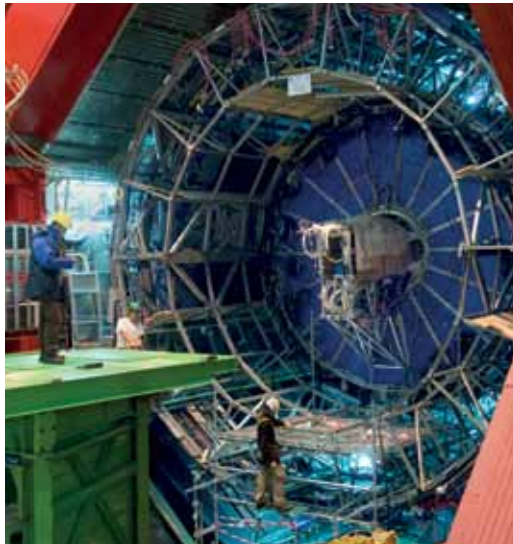
ALICE-kokeen pääaratailmaisimen rakentamista CERNissä.
