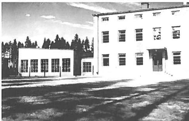
Kuva 5. Veljekset Karhumäki Oy:n konttori ja sen takana tehdas valmiina 1940. Ti 80, VKA.
