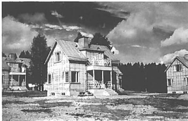
Kuva 10. Torpparinkujan talojen erityispiirteenä olivat nurkkaikkunat. Ti 70, VKA.
