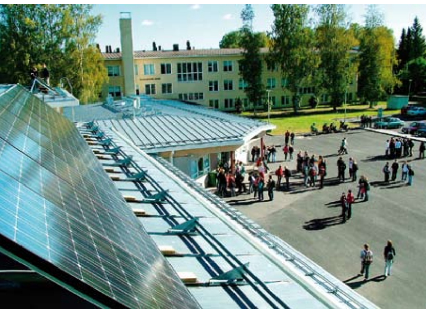
Aurinkopaneelisto toimii sekä koulun opetus- ja laboratoriolaitteena että yliopiston tutkimuslaitteena.
