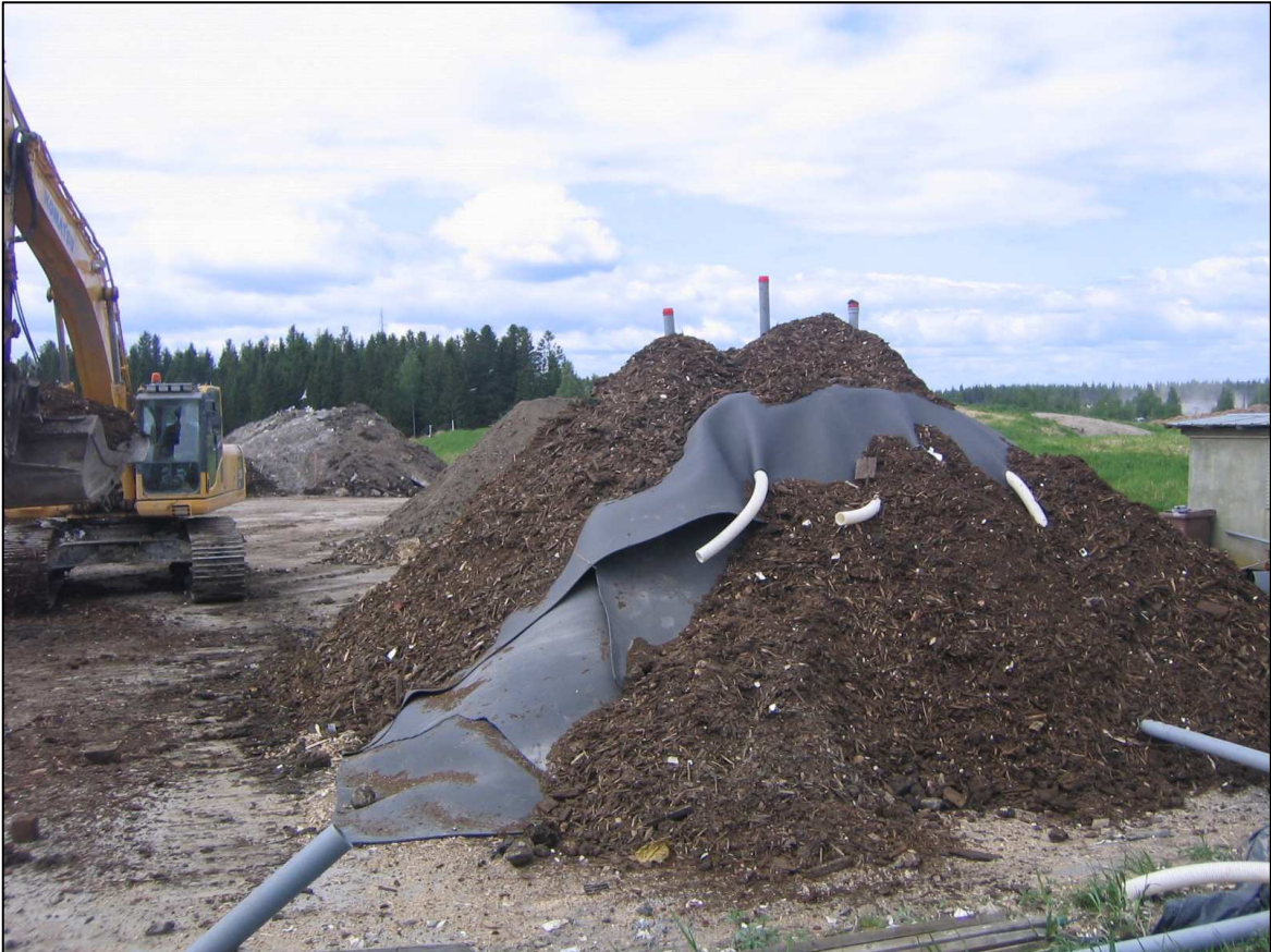
Kuva 10: Ilmastettussa sekä lämpöeristetyssä aumassa pilaantunut maa-aines eristettiin routamatolla ja ilmakiertoa parannettiin salaojaputkituksen sekä imupumpun avulla.
