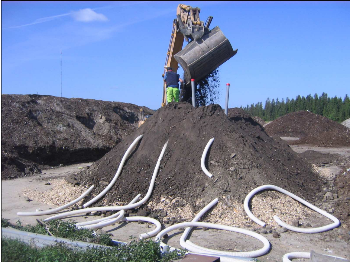
Kuva 8: Painovoimaisesti ilmastettuun aumaan asennettiin ilmakiertoa parantavat salaojaputket (3 kpl) kahteen kerrokseen. Ylemmistä putkista nostettiin havaintoputket auman pintakerroksen yläpuolelle näytteenottoa varten.
