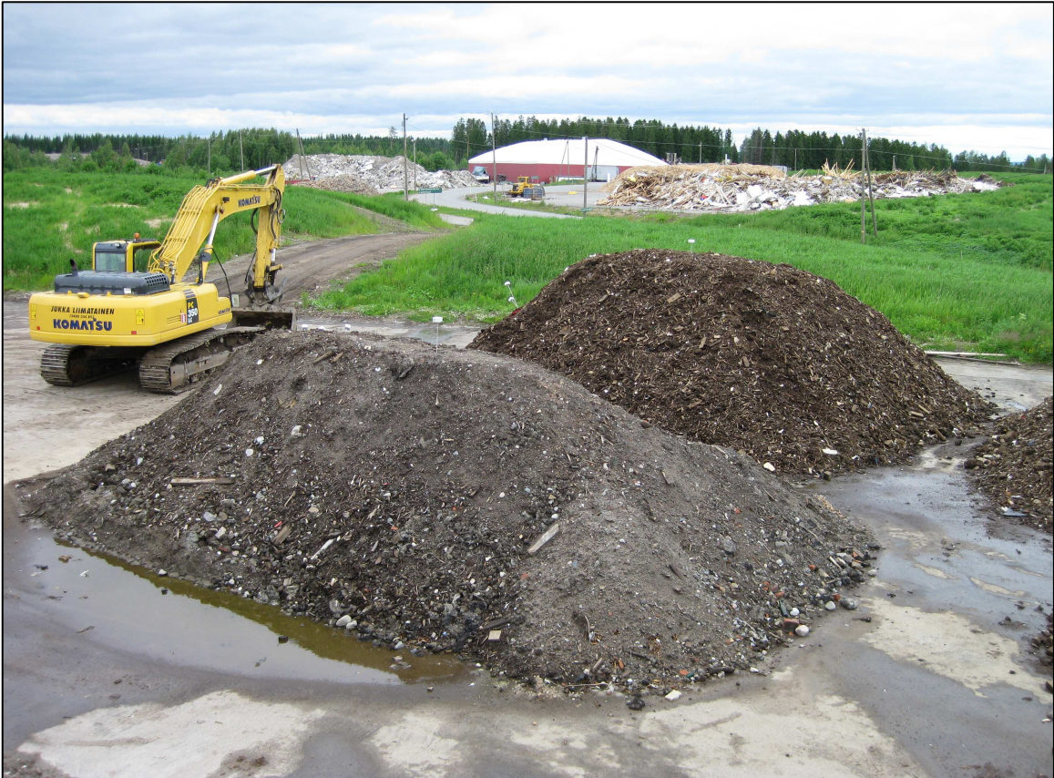
Kuva 7: Vertailuauma (koeauma 0 edessä) ja lämpöeristetty auma (koeauma 2 taustalla) valmiiksi rakennettuina.
