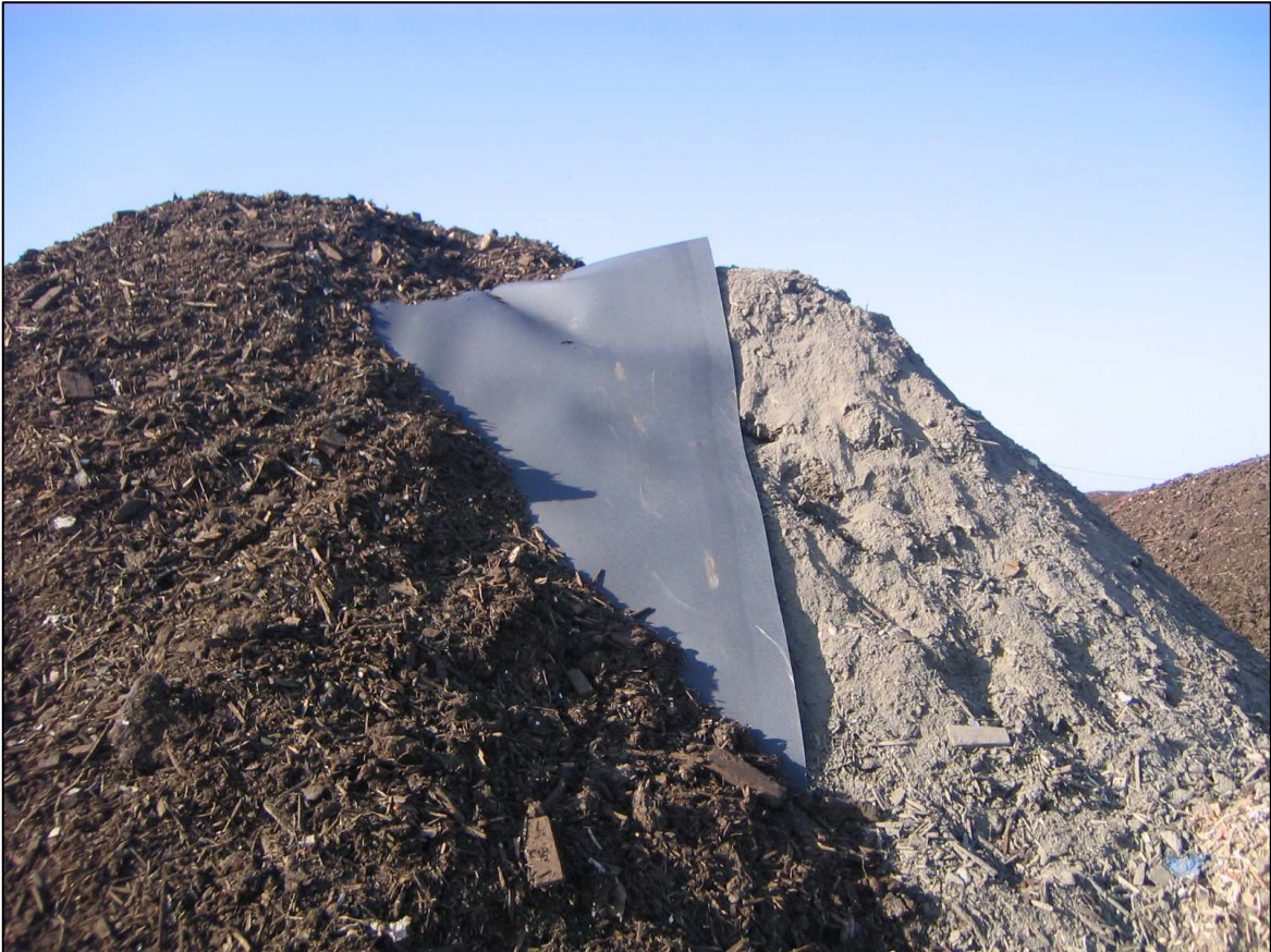
Kuva 9: Lämpöeristetyssä aumassa pilaantunut maa-aines eristettiin routamatolla sekä seulomattomalla puhdistamolietekompostilla.
