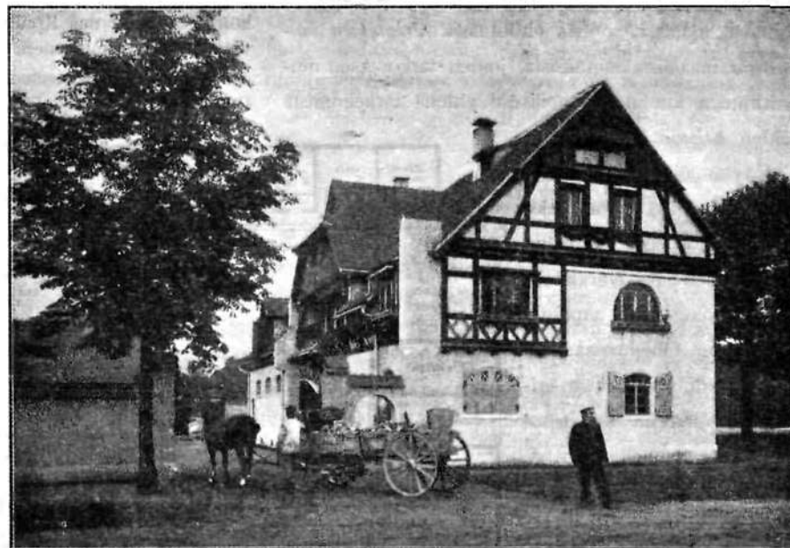
Asuin- ja tallirakennus. Ulkopääty. Maalaismallitalo Saksan rakennusnäyttelystä Dresdenissä v. 1900. Kuv. 1. Arkkit, Ernst Kühn.
